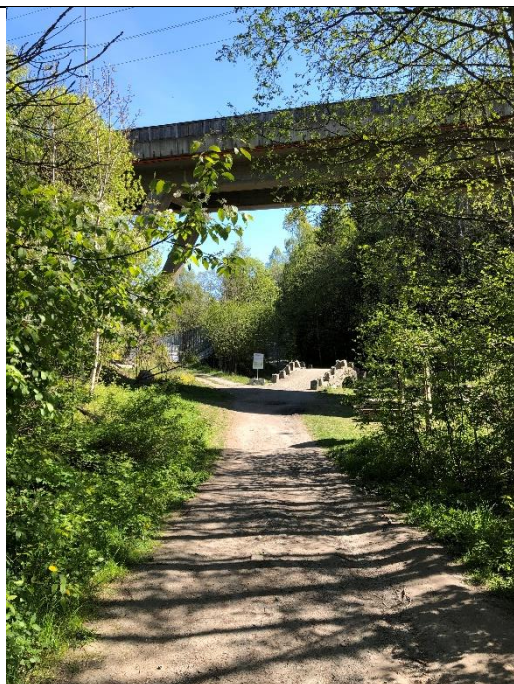
Utsikt fra Mølleveien/Fredrikshaldske Kongevei, sett sørover mot steinhvelvingsbrua og bru for fv. 156.
