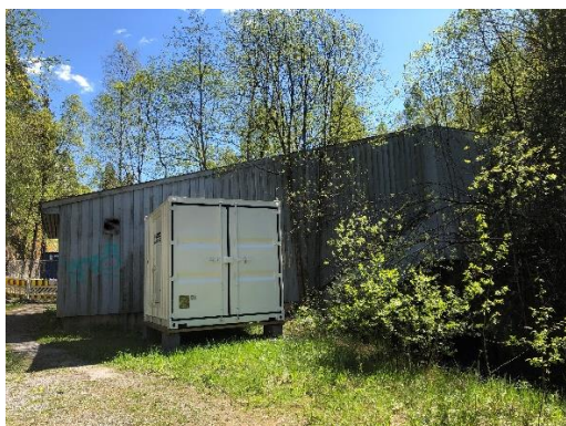
Haugbro pumpestasjon som skal rives.
