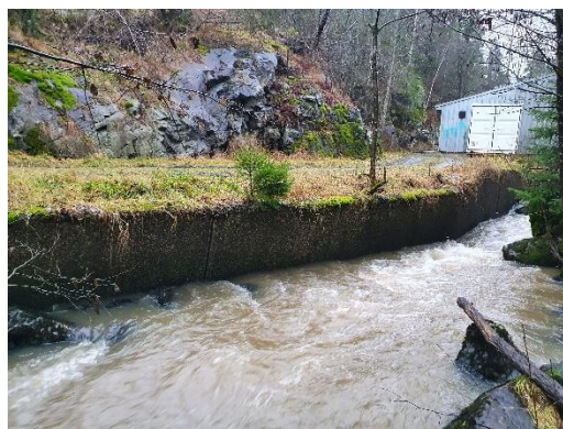
Dalsbekken nedstrøms pumpestasjonen. støttemur til venstre.
