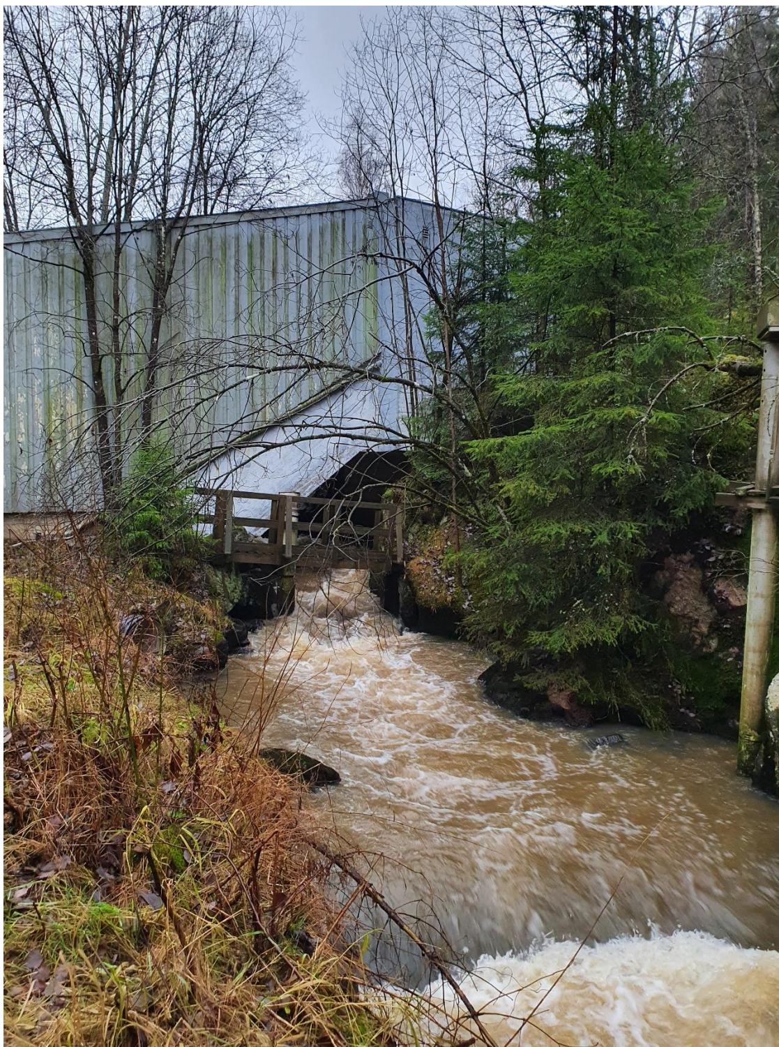
Haugbro pumpestasjon – rives og erstattes med en rørbru.
