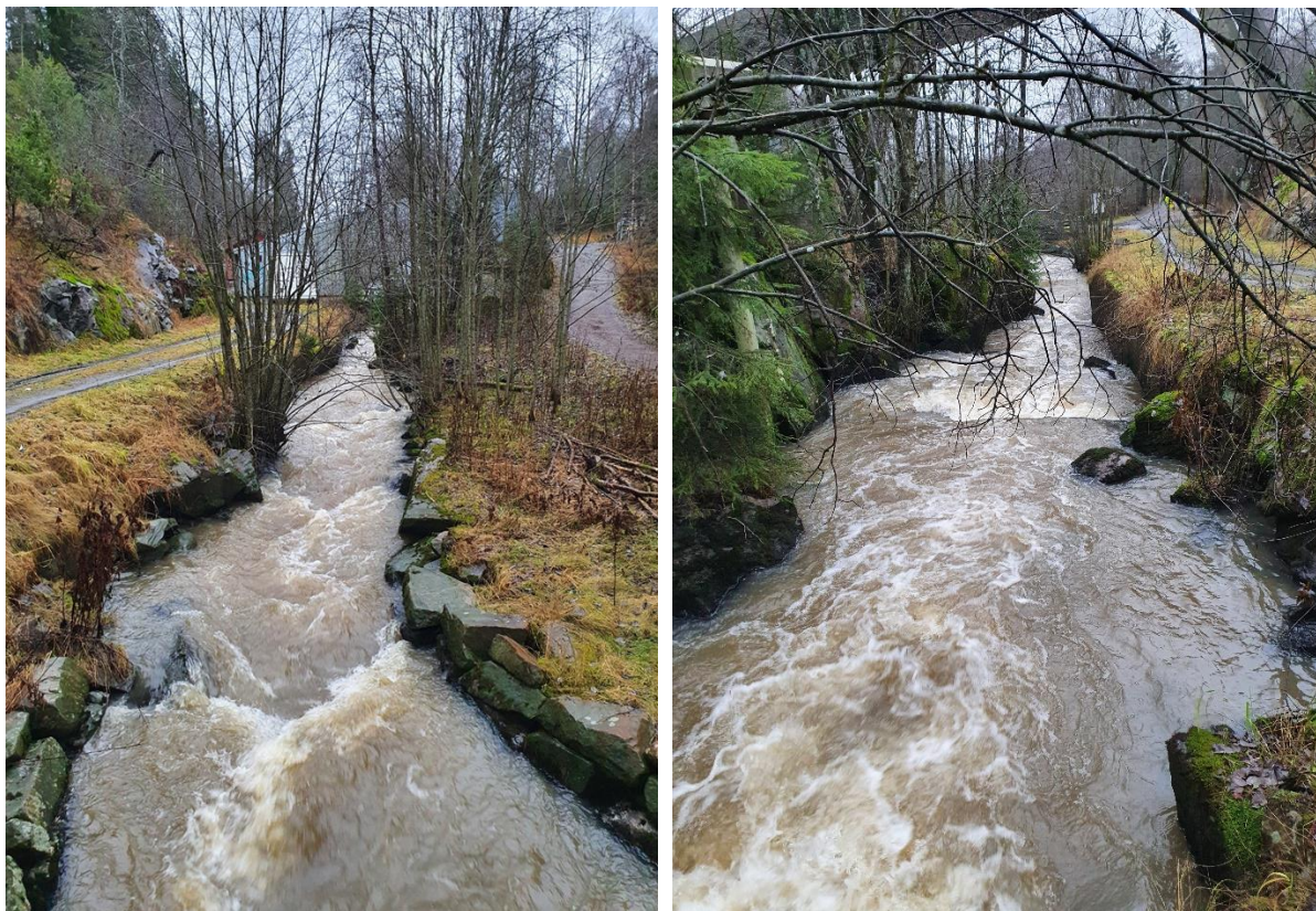
Figur 2 Bildene viser elvestrekningen som skal legges i en midlertidig bekkelukking. Til venstre er bilde tatt opp mot Haugbro PST og til høyre er bildet tatt ved Haugbro PST sett ned mot Gjersjøen. Foto: Anne Johanne Rognstad, Sweco (10.12.2020).
