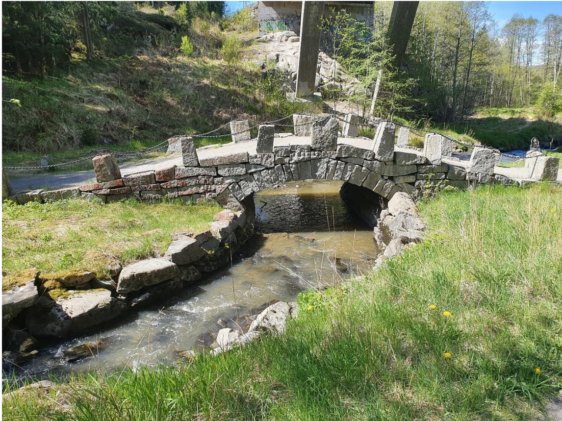
Steinhvelvsbrua og deler av Fredrikshaldske Kongevei. Bruen ligger rett nedstrøms bekkelukkingen og vil ikke bli berørt av tiltaket.
