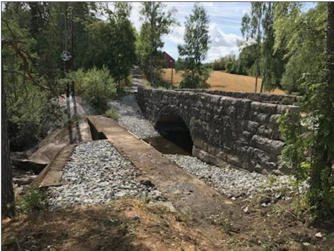
Figur 5: Dam situasjon etter 2018 (før kappestøp ble utført)
