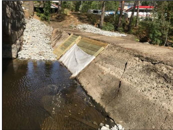
Figur 6: Terskelsituasjon før 2018 (bilde fra oppstrøm)
