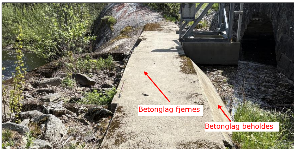
Figur 10: Betonglag damkrona og damskråning
