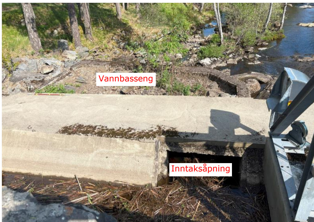
Figur 13: Vannbasseng og inntaksåpning
