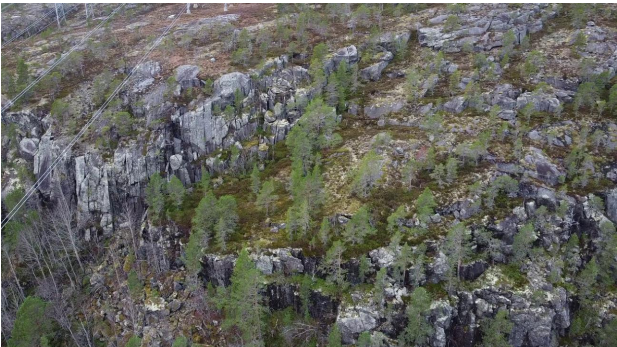
Figur 13: Øvre del av vestlig side. Oppsprekkingen viser steile sprekker og ett plant sprekkesett. Det er ingen tydelige tegn som indikerer steinskredfare, men det kan løsne mindre blokk som steinsprang.
