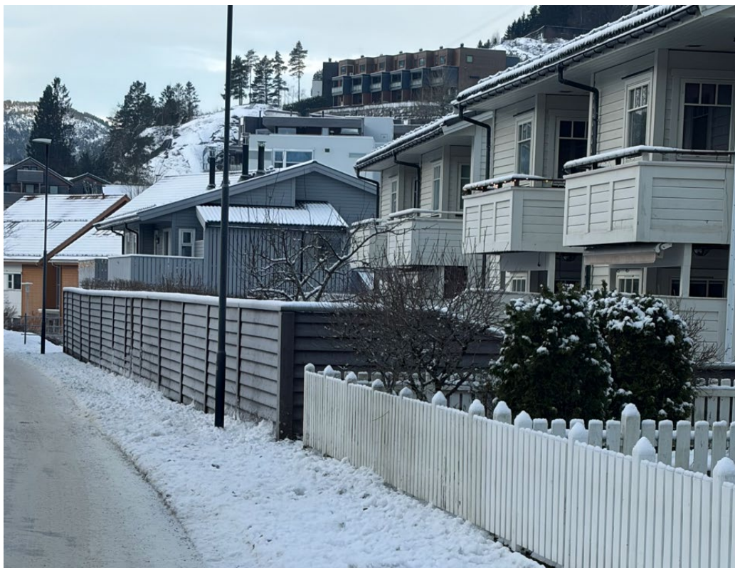
Figur 3. Hagene i Falkensteinsvegen hvor gamle kabler søkes lagt igjen. Kyrkjevegen sees til venstre, bildet er tatt fra øst mot vest.
