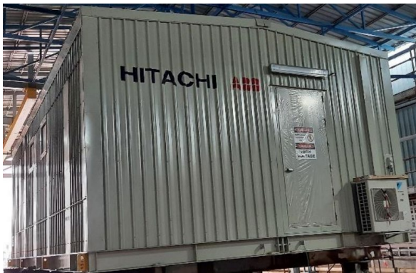
Figur 12 Planlagt container for 24 kV bryteranlegg, det blir plassert 3 slike på hver transformatorstasjon
