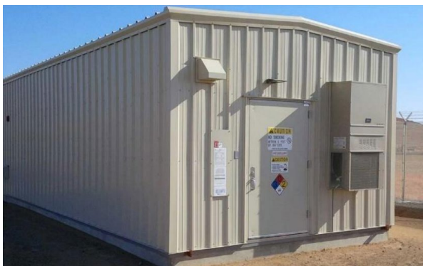
Figur 14 Planlagt container for 132 kV bryteranlegg, det blir plassert 2 slike på hver transformatorstasjon.
