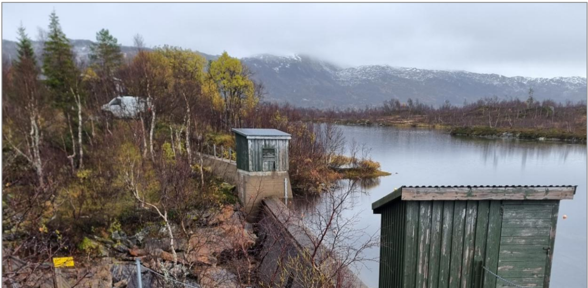
Figur 4-2. Rauvatn dam med kantvegetasjon i bakgrunnen som blir påvirket. Det blir en adkomst på oppstrøms og en på nedstrøms side av dammen.
