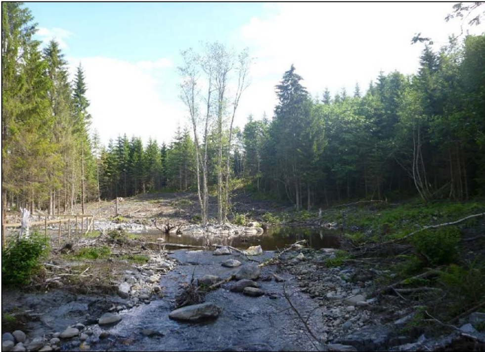
Figur 4: Hofstadelva etter endt sikringsarbeid
