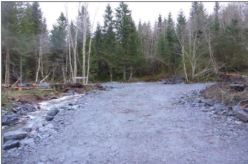
Figur 3: Hofstadelva etter utkjøring av steinmasser. Midlertidig løp ved siden av anleggsveien
