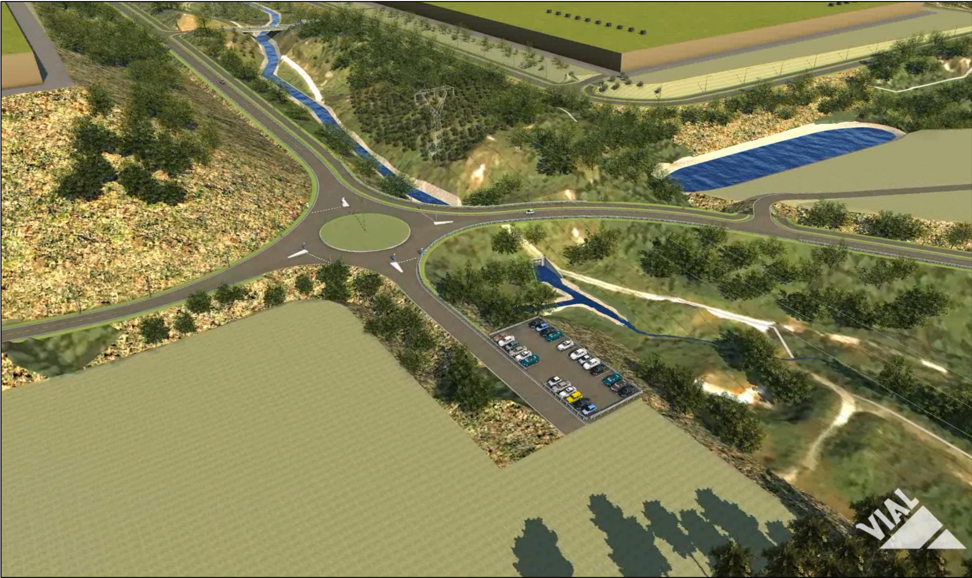
Figur 2. Vannløp, kulvert under rundkjøring i sør, retning mot nord-øst
