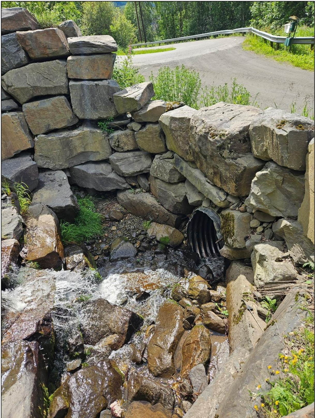
Figur 4: Stikkrenne for Høvrebekken i S-sving av Midtbygdsvegen (GPS punkt 918 i Figur 11).
