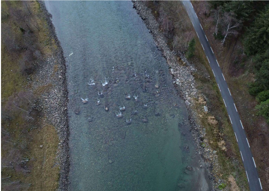
Bilete 21 – dronefoto av terskel etter tiltak.
