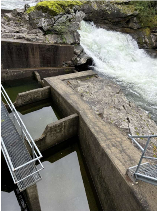
Bilete 23 og 24 - syner fisketrapp Husum(t.v.) og inntak oppstrøms Svartagjel(t.h.), (ØE).
