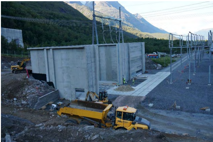
Figur 3: Eksempel på transformatorsjakter i betong
