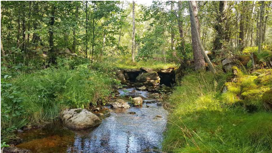
Figur 12: En av bruene ved Søralløypa. Begge bruene befinner seg øst for innkjørselsveien til parkeringsplassen på Sørøst, like nord for Onarheimsvegen 50. Foto: Sweco
