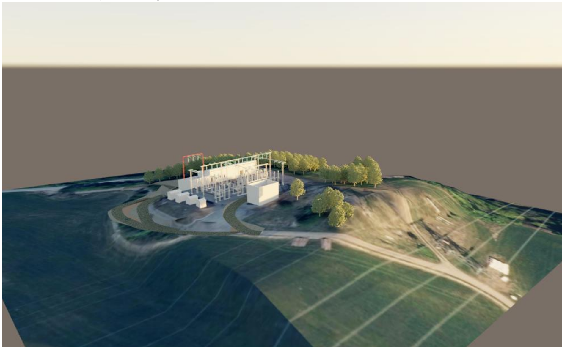
Sørtveit transformatorstasjon sett i retning nordøst
