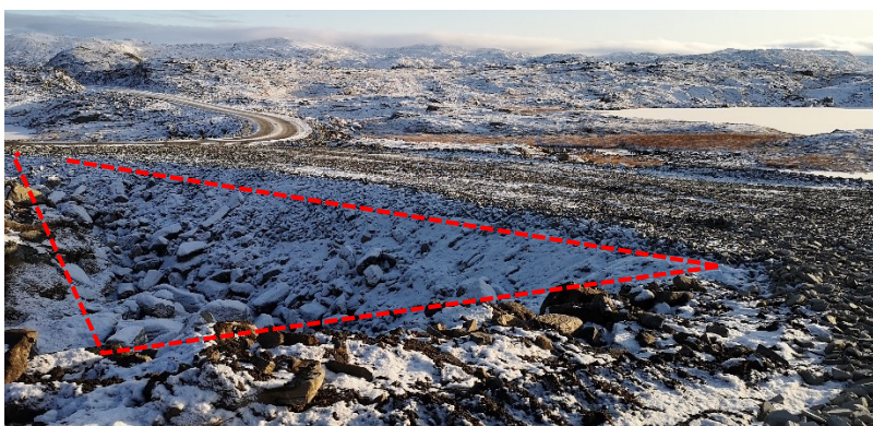
Bilde 8: Den nye veien danner et restareal i form av en forsinking i «V-en» mellom veiene til T5 og T6.
