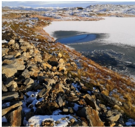
Bilde 3 og 4: Gode avgrensninger av fylling mot terreng og vann (til høyre)
