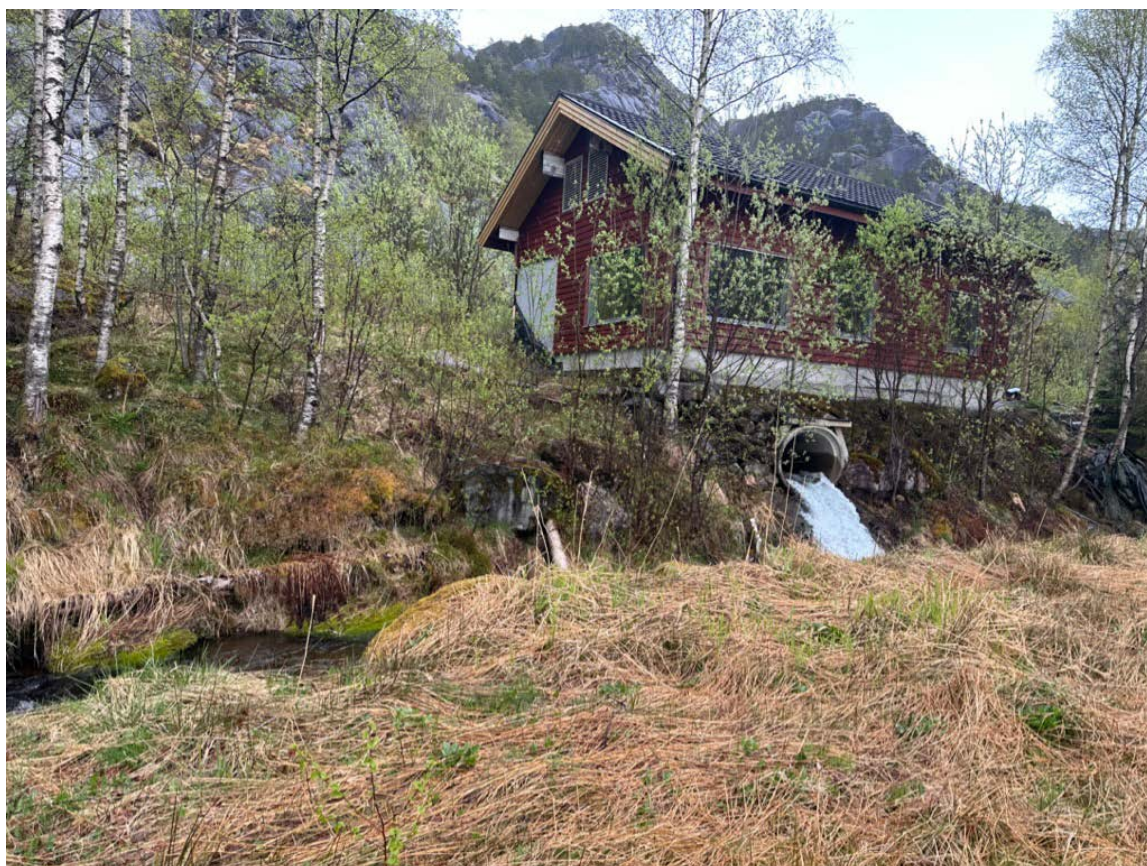
Figur 5. Kraftstasjonen ligg omlag 60-70 meter aust for Kvangrefossen. Produksjonsvatnet går i kanal tilbake til Kvanngreelva.
