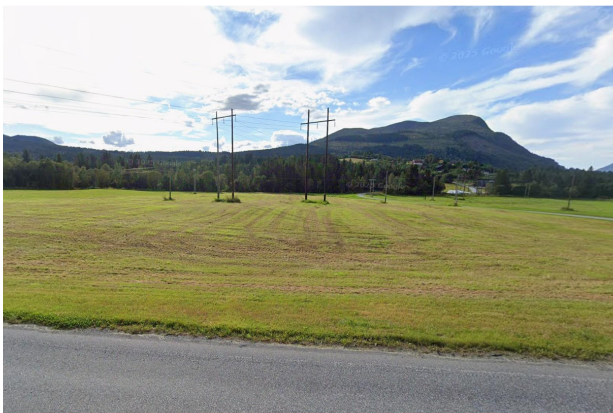
Figur 2-13. Eksisterende ledninger mellom Ørsta og Haugen. Sett fra Fv665 retning Ørsta TS (øverst) og Haugen TS (nederst).
