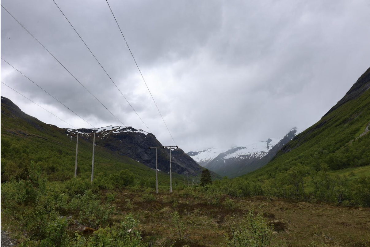
Figur 2-12. Dagens 66 kV-ledninger ytterst i Bakkedalen. Foto Norconsult.
