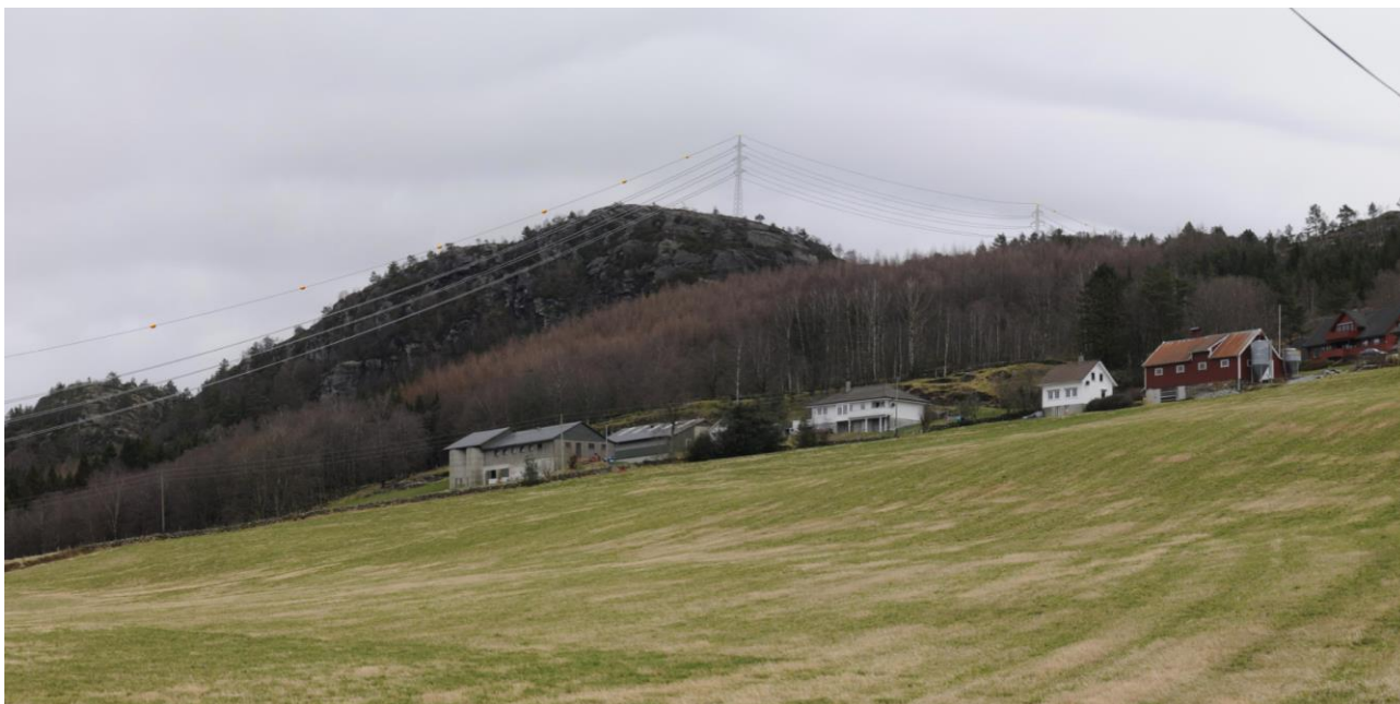
Figur 4-9 Ny 132 kV-ledning ved Risanger, alt. 1.2 b, utsnitt av panorama (se vedlegg 4). Traseen er trukket nordover og høyere i terrenget for å unngå ryddegate gjennom plantefelt ved Risanger. For å heve spennet over plantefeltet kreves en mast på Ravnafjellet. Dette gir et langt og høyt spenn som må merkes med flymarkører på topplina. Masta kreves malt i signalgul farge, eller med rød og hvite striper.
