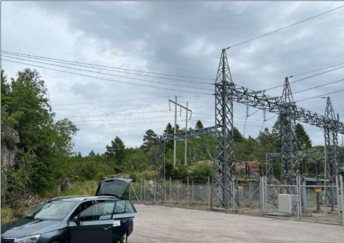
Figur 5-15. Ny ledning kobles til et nytt innstrekkestativ på vestsiden av dagens anlegg.
