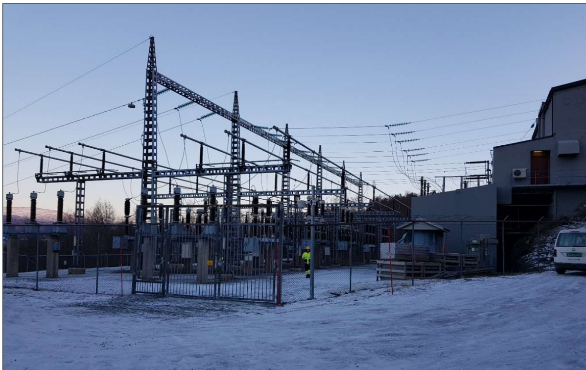
Figur 4-3. Eksempel på 132 kV-transformatorstasjon med utendørs koblingsanlegg (AIS).
