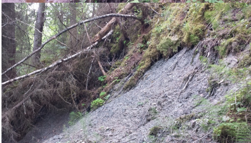
Figur 2: (Topp) Bilde nr. 2 som viser løsmasse i bekken. (Midten) Bilde nr. 3 som viser sig i skråningene. (Nederst) Bilde nr. 4 som viser noe overflateskred langs bekken.
