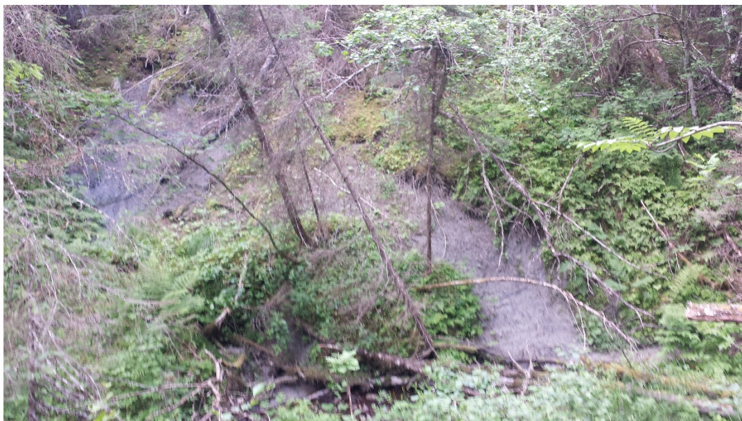
Figur 3: Bilde nr. 5 som viser noe overflateskred langs bekken.
