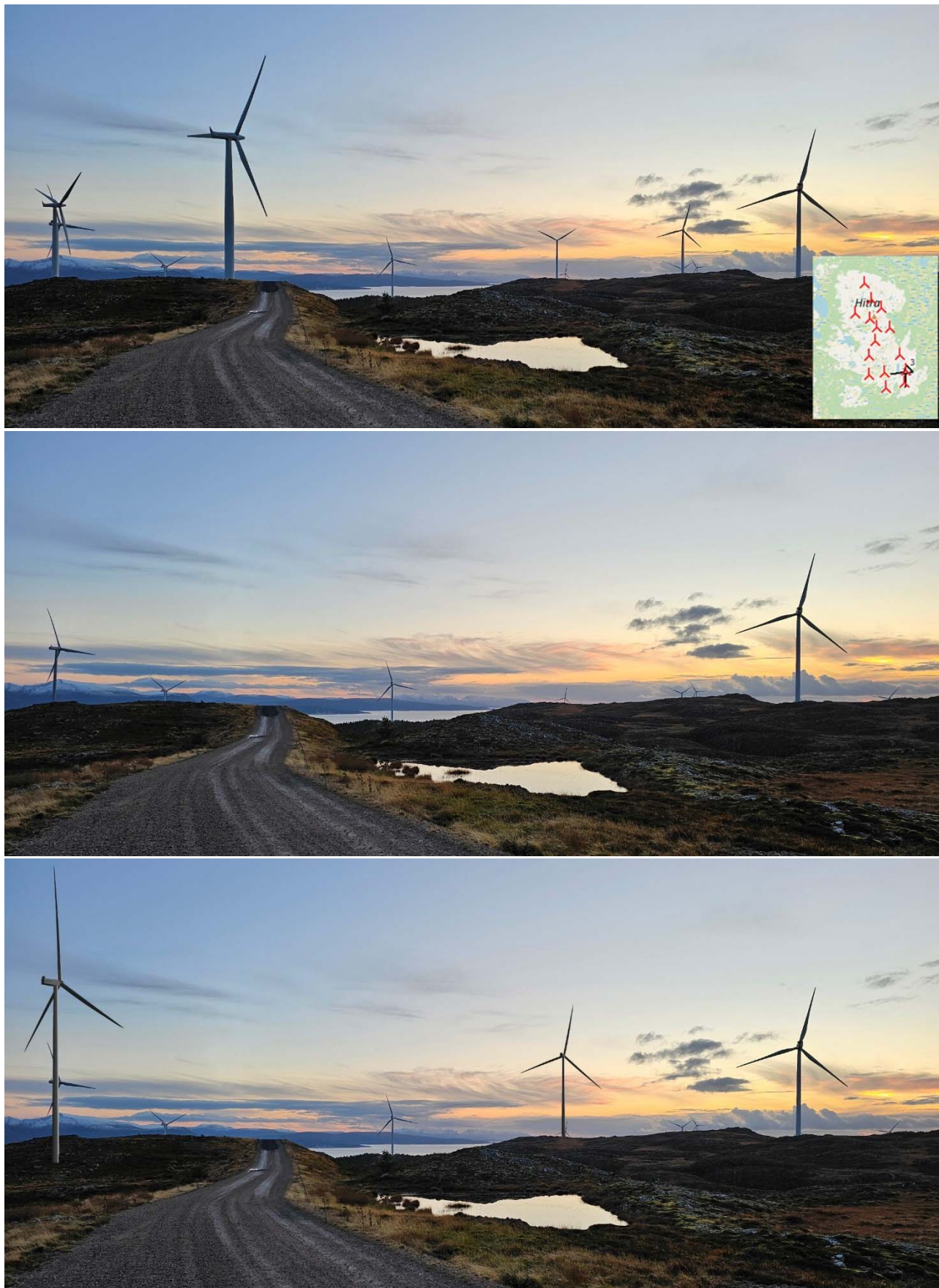
Figur 5-19: Hitra Vindkraftverk sett fra planområdet, ved VT14 mot sørvest (standpunkt 3 fra Figur 5-15) . Eksisterende situasjon øverst, 0-alternativet, der Hitra 1 er sanert bort, i midten, og Nye Hitra 1 vindkraftverk nederst.
