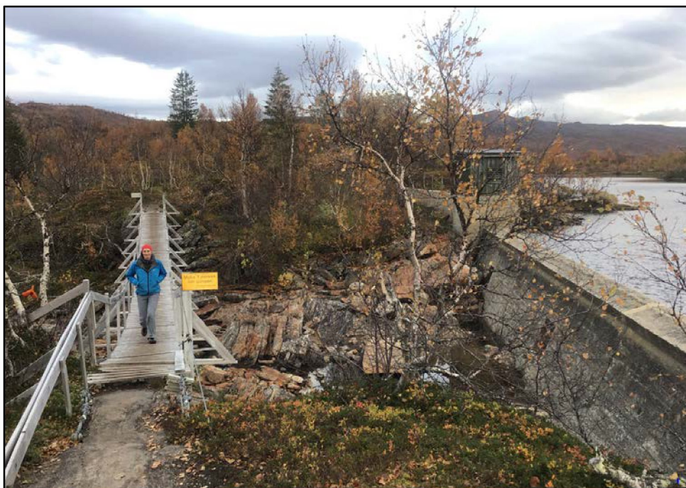
Figur 5-1. Tilrettelegging for utfart ved damanlegget Rauvatn.
