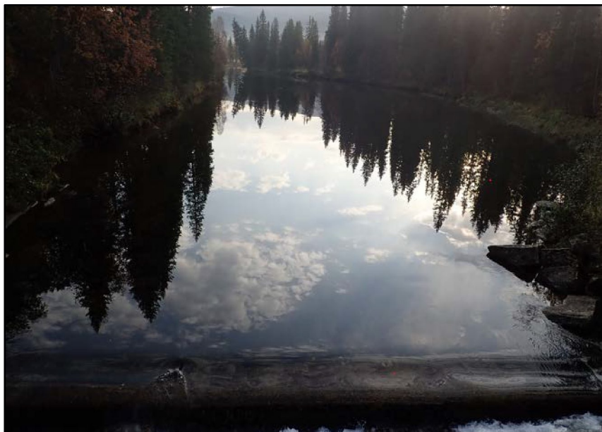
Figur 4-6. Betongterskel øverst på anadrom strekning som hever vannspeilet oppstrøms
