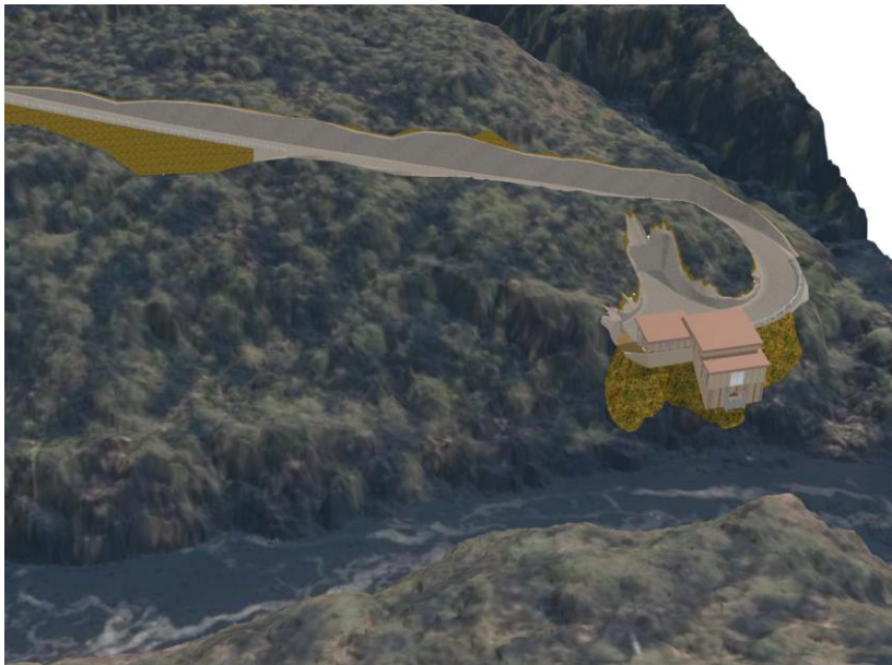
Figur 7, Gjosa Kraftverk, stasjon med sidebygg for trafo
