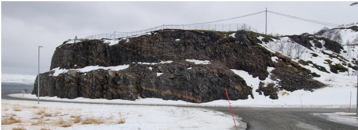
Figur 24: Sprengt bergskjæring. Bilde tatt mot S.
