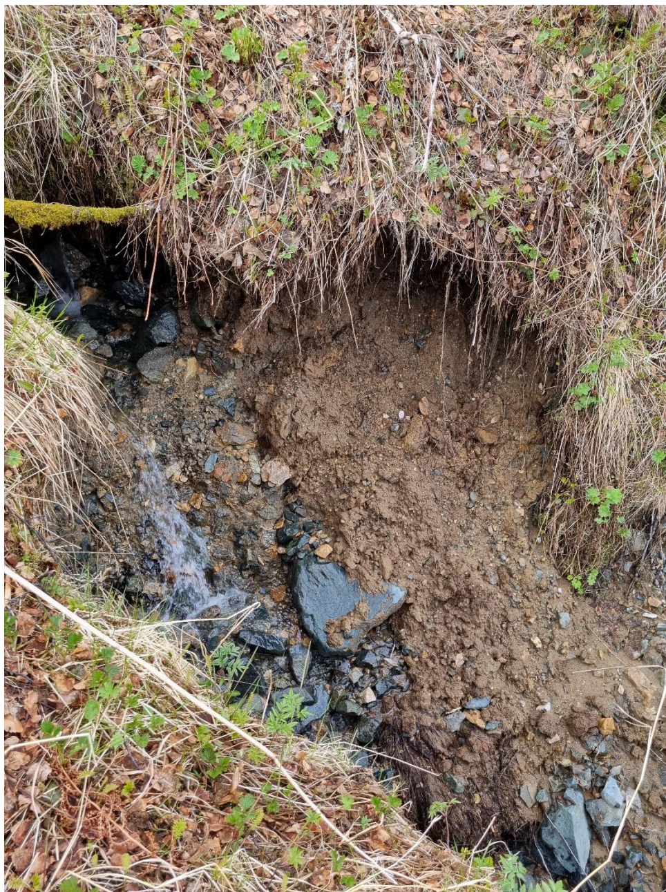
Figur 32: Bilde langsmed Litjeelva. Viser nylig erosjon og lett eroderbare masser.
