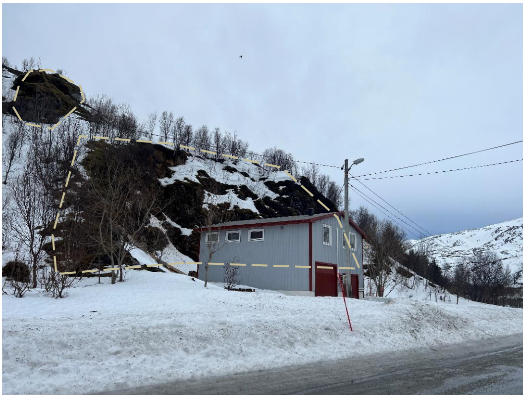
Figur 26: Hus nr. 764, med eksisterende bergskjæring i bakkant. Løsneområder steinsprang markert. Bilde tatt mot Ø.
