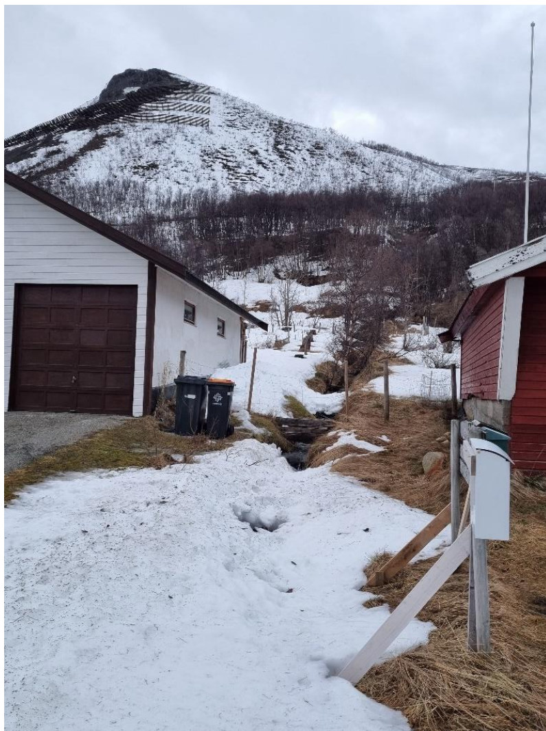
Figur 52: Bekk 3, samt støtteforebygninger som er etablert i fjellsiden, synes i bakkant. Sett mot nordøst.
