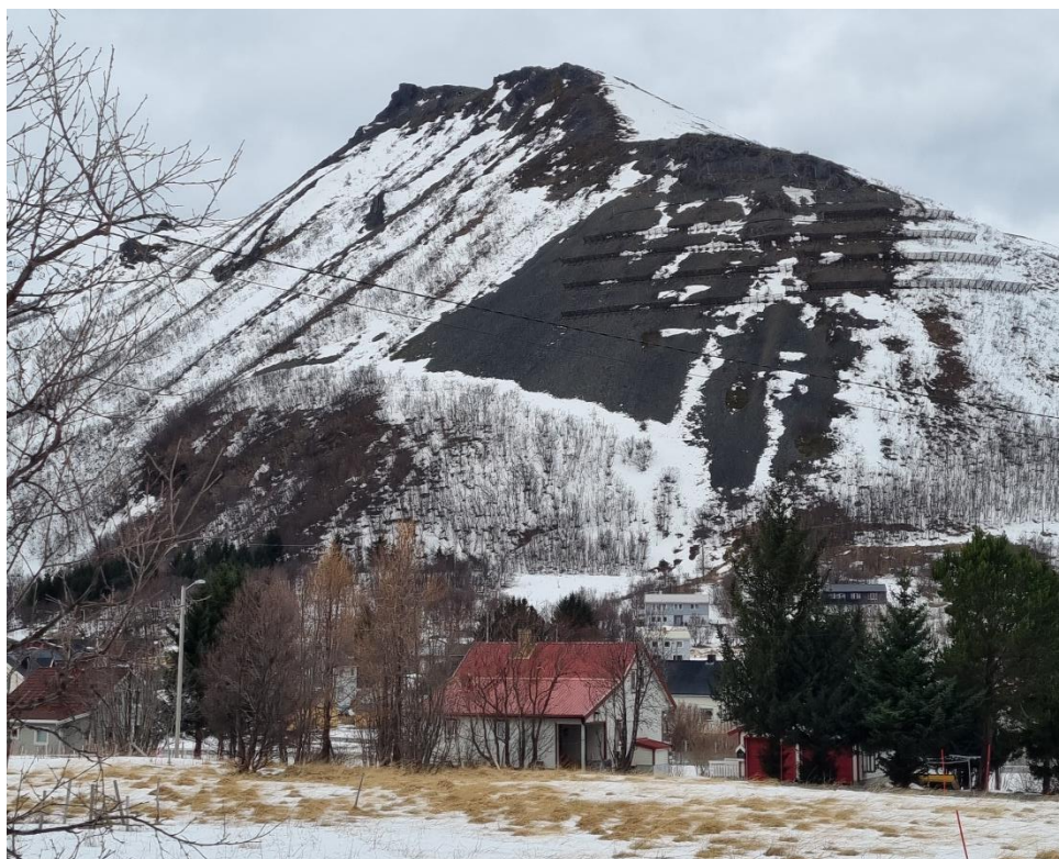
Figur 11: Bilde av sikringstiltakene nedenfor Vannhaugen. Bilde tatt i februar 2023, sett mot nordvest.
