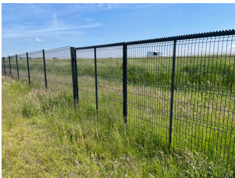
Figur 6 Illustrasjon av gjerde med port. Bilde fra Energeias solkraftverk i Nederland
