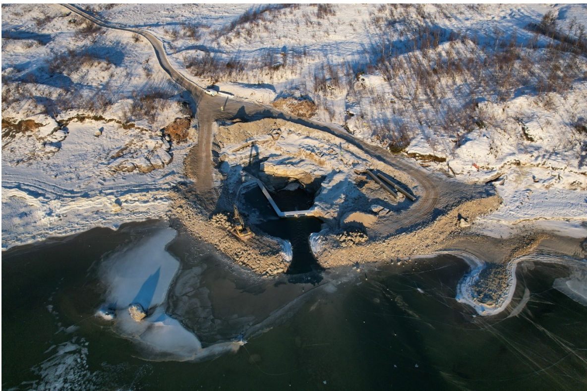
Vedlegg 24: Bilde 10 Anleggsområde, terskel og fangdam
