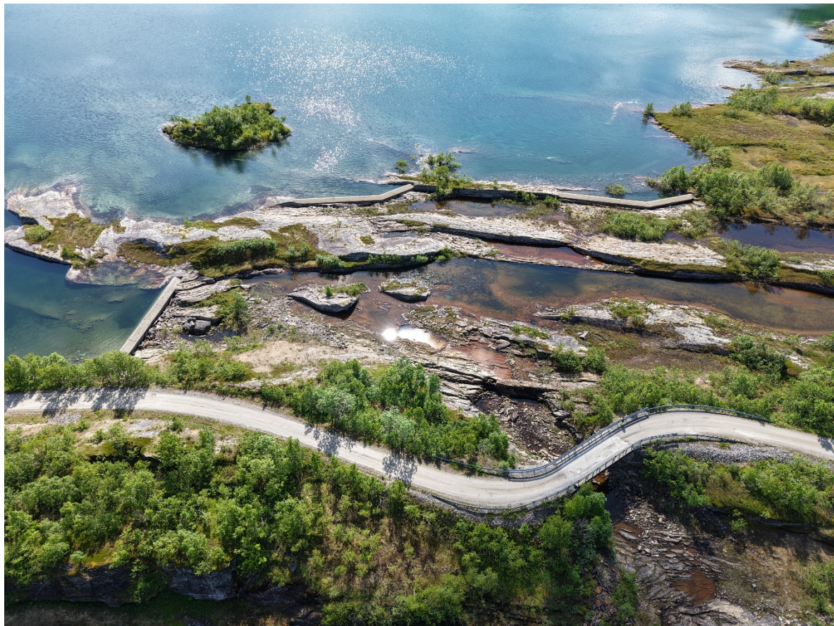
Vedlegg 10: Bru nr.3 Kjensvasshøvet bru 2, dam 3 - 5 – bilde 1
