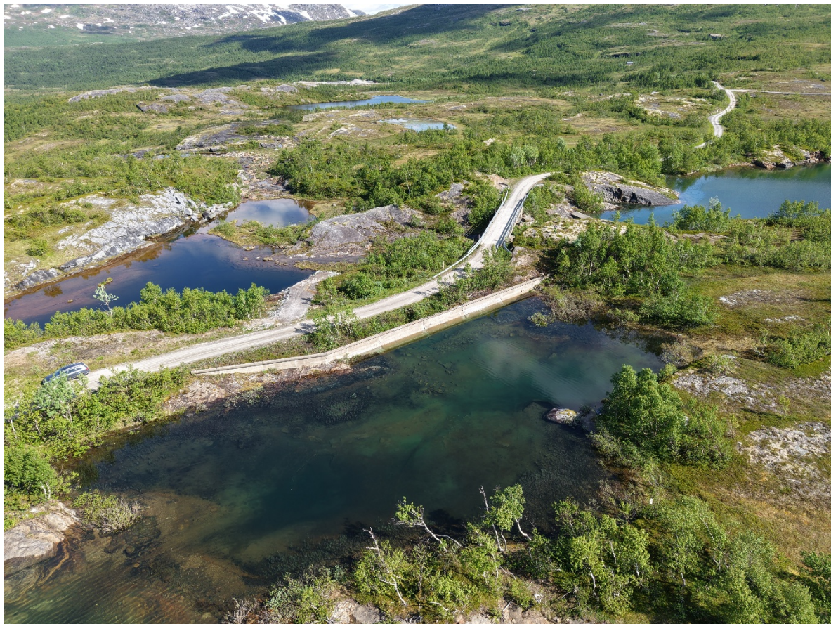
Vedlegg 8: Bru nr.2 Kjensvasshøvet bru 1, dam 2 – bilde 2
