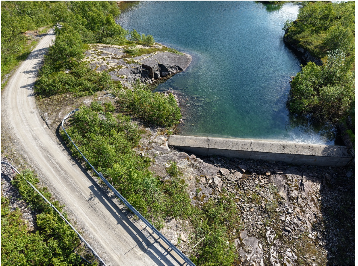
Vedlegg 7: Bru nr.2 Kjensvasshøvet bru 1, dam 1 – bilde 1
