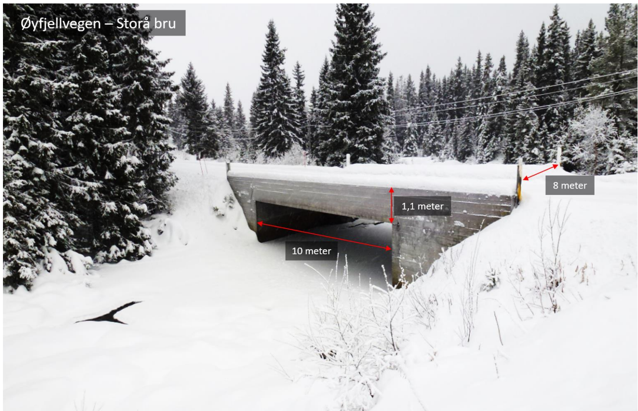
Figur 7 Storå bru langs Øyfjellvegen
