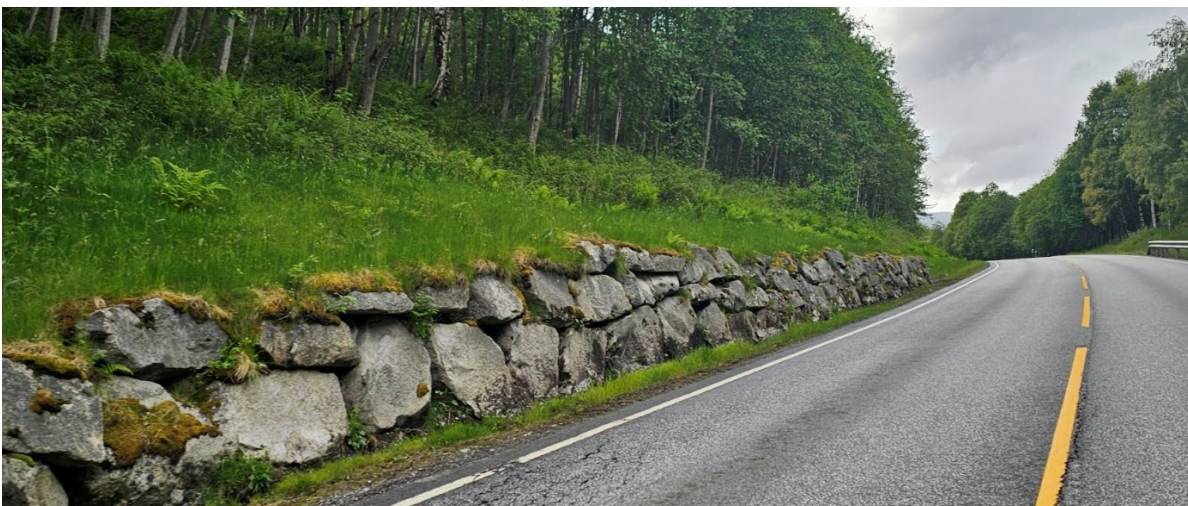
Figur 5-8: Eksisterende murer og skjæringer er i utgangspunktet ikke planlagt berørt av inngrepene.
