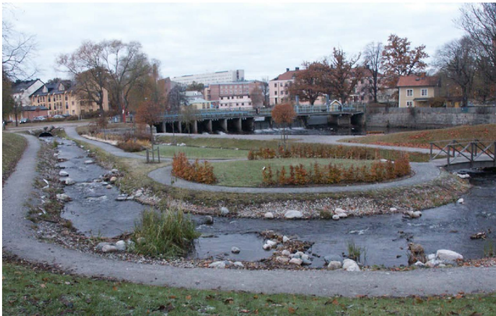
Figur 18. Omlöpet Slussen, Svartån, Örebro. Här återskapades den strömsträcka som för över 100 år sedan försvann när Svartån dämades och en sluss byggdes 1886. Det är fem km till närmaste strömsträckor uppströms i ån och strax nedströms ligger Hjälmaren. Foto Erik Degerman.
