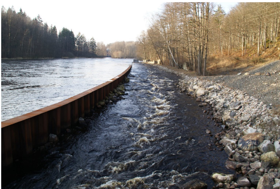
Figur 7. Inlöp vid Hemsjö övre, Mörrumsån. Stålspont gör att vandringsvägen hålls öppen utmed stranden, samtidigt som vandringsvägen fungerar som extra utlopp vid höglöden. Vattenföringen i vandringsvägen regleras av ett utskov i övre delen. Foto Erik Degerman.
