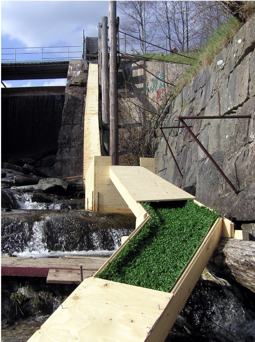
Figur 16. Ålledare med "konstgräs" under konstruktion vid Hedefors i Sävåån. Foto Stefan Larsson.
