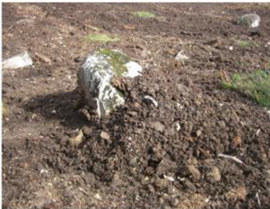
Figur 3-1: Eksempel på stein som er plassert i riktig dybde med den patinerte overflaten opp. Hentet fra: istandsettingsplanen for Songa og Trolldalen. Foto: Per Anker Pedersen
