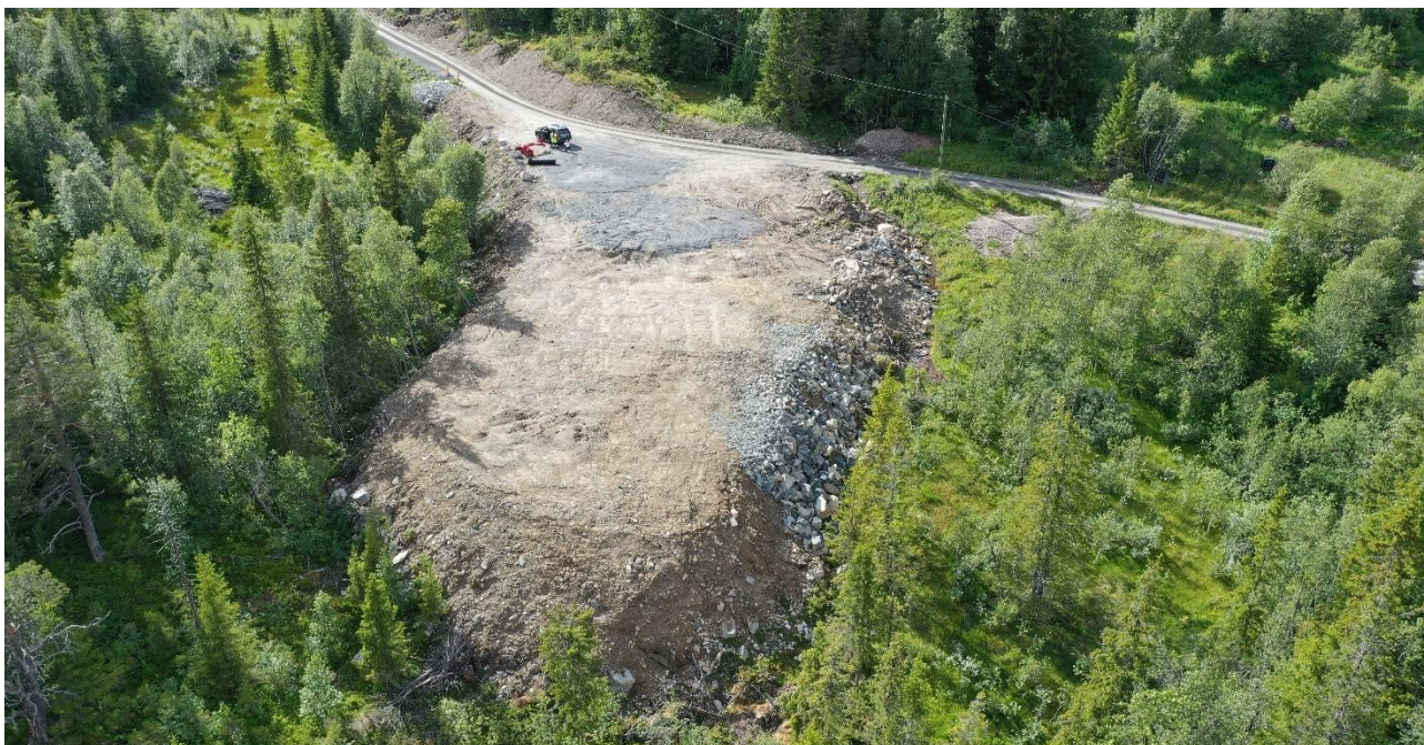
Figur 3-46: Steinsbøle deponi ble opparbeidet som en flate under utbedringen av Kalhovdveien.
