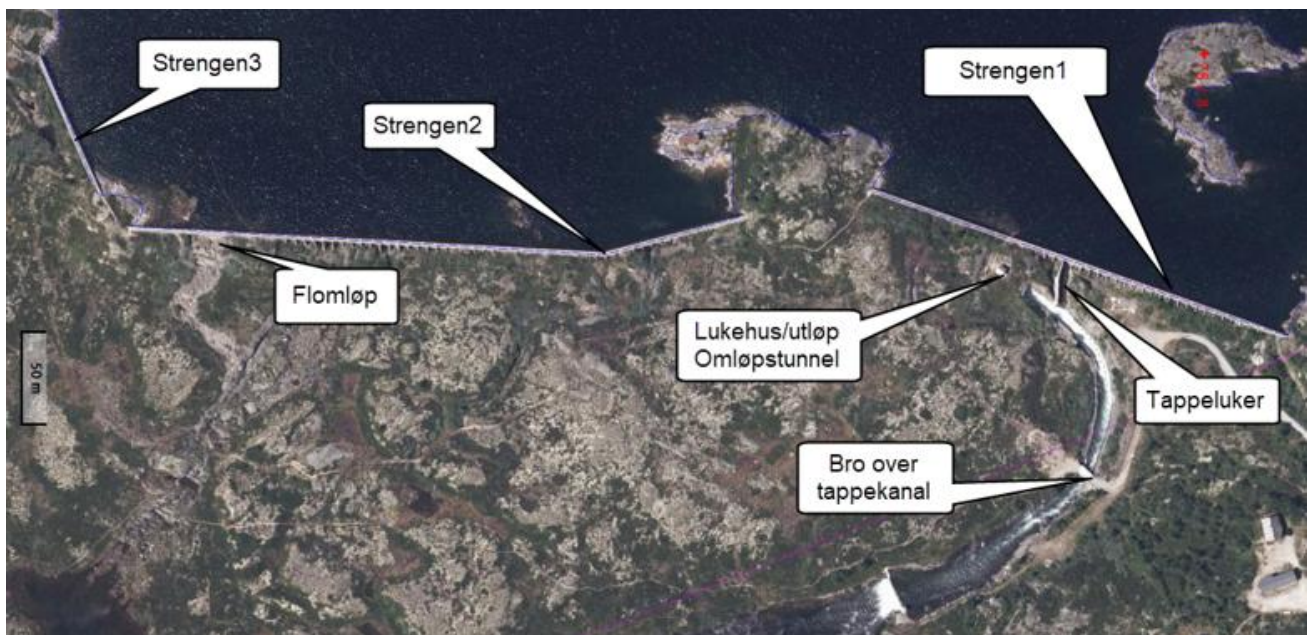
Figur 1-5. Eksisterende situasjon ved dammer Strengen (ortofoto: norgeskart.no)
