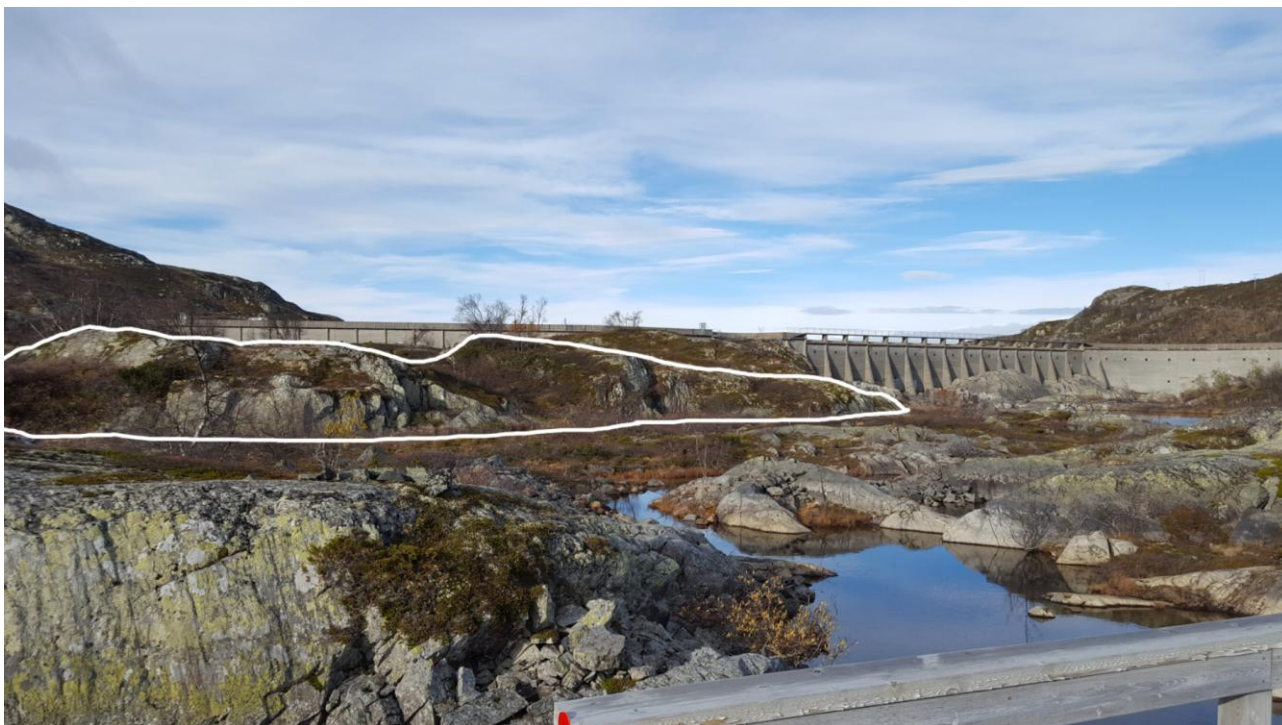
Figur 3-41. Området nedstrøms dam Grotte der det etableres riggområde. Terrengform som bevares gjennom anleggsperioden er markert med hvit linje. Riggområdet anlegges rundt denne.
