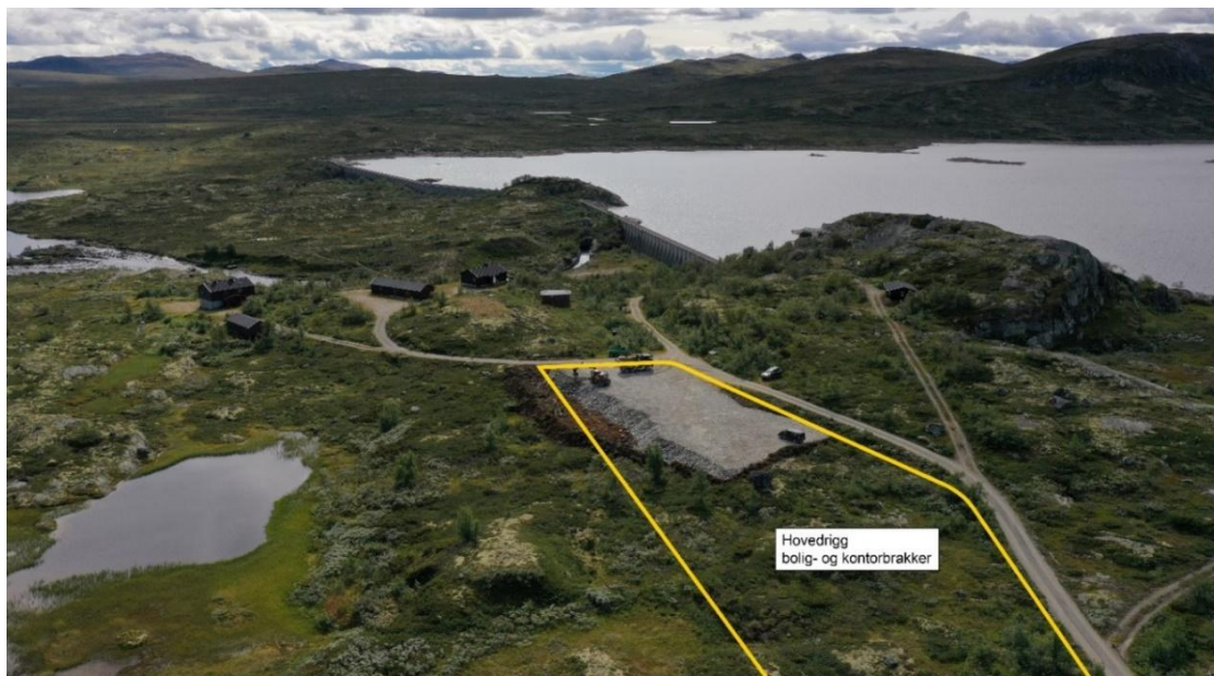
Figur 3-27. Område for hovedrigg for alle damprosjektene ved Strengen. Bildet er tatt i forbindelse med opparbeidelse av riggområde for oppgradering av Kalhovdvegen.
