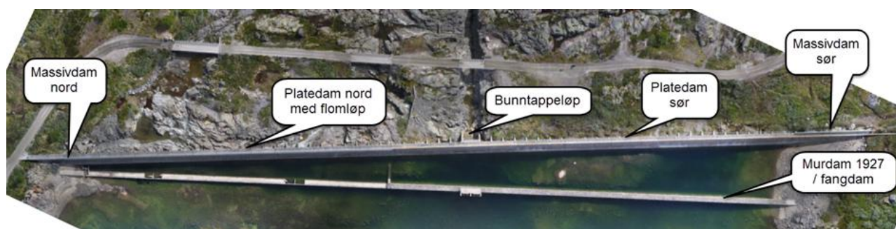
Figur 1-3. Eksisterende situasjon ved dam Kalhovd, oversikt (dronebilde Skanska 2017)
