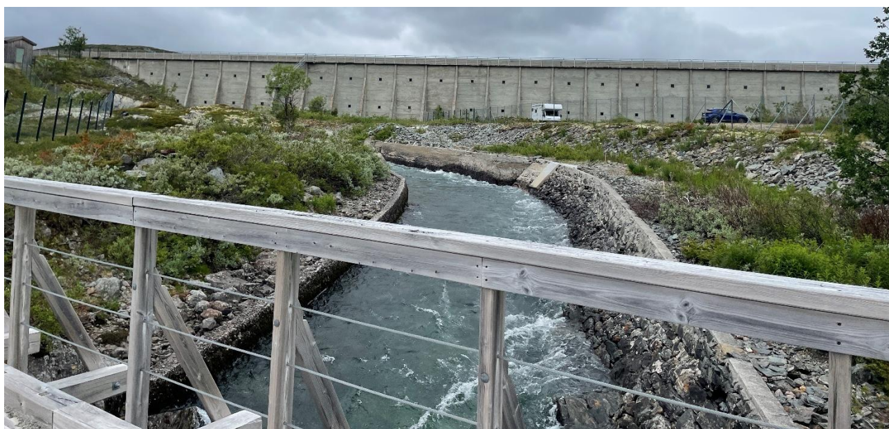
Figur 3-26. Eksisterende tappekanal sett fra bro. Strengen I i bakgrunnen. Skråningen inn mot tappekanalen (til høyre i bildet) slakes ut og tildekkes med toppmasser.
