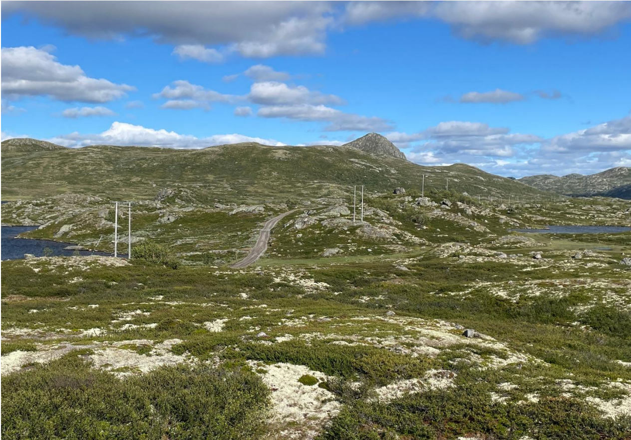
Figur 3-47. Eksisterende kraftledning langs Kalhovdvegen. Bildet er tatt i veikrysset ved adkomstvei til dammer Strengen.
