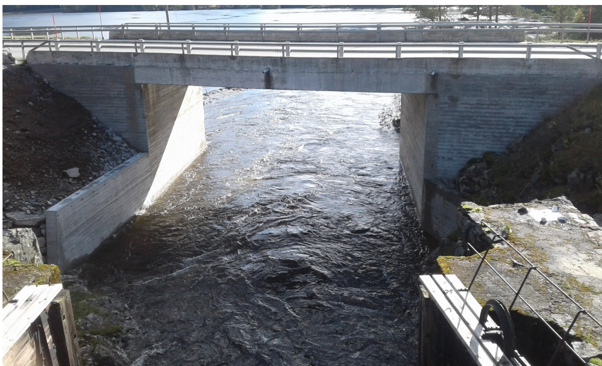
Bilete av det «andre løpet» ved Storestraumen 3. oktober 2017. Slusene til Bjoren kan sjåast i forkant.
