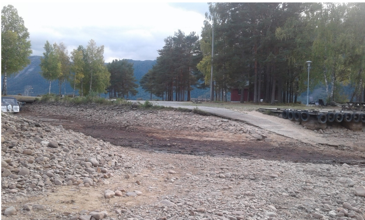
Bilete syner båtslipp og innløp til bryggjeanlegg ved Prestnest i Bygland 16. september 2021. Vasstanden er på kote 200,63.
