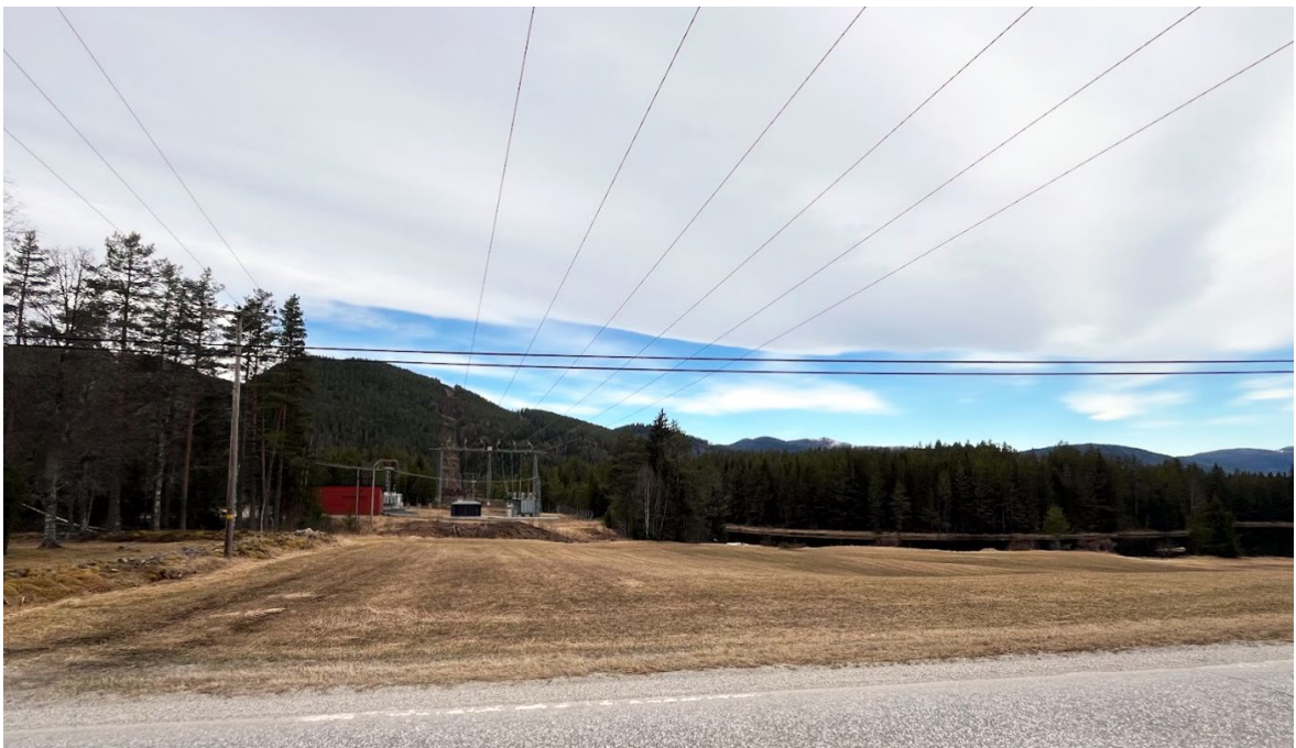
Figur 9-17: Foto av delområdet sett fra Fyresdalsvegen. Foto ved transformator stasjon Einangsmoen. Kilde: COWI
