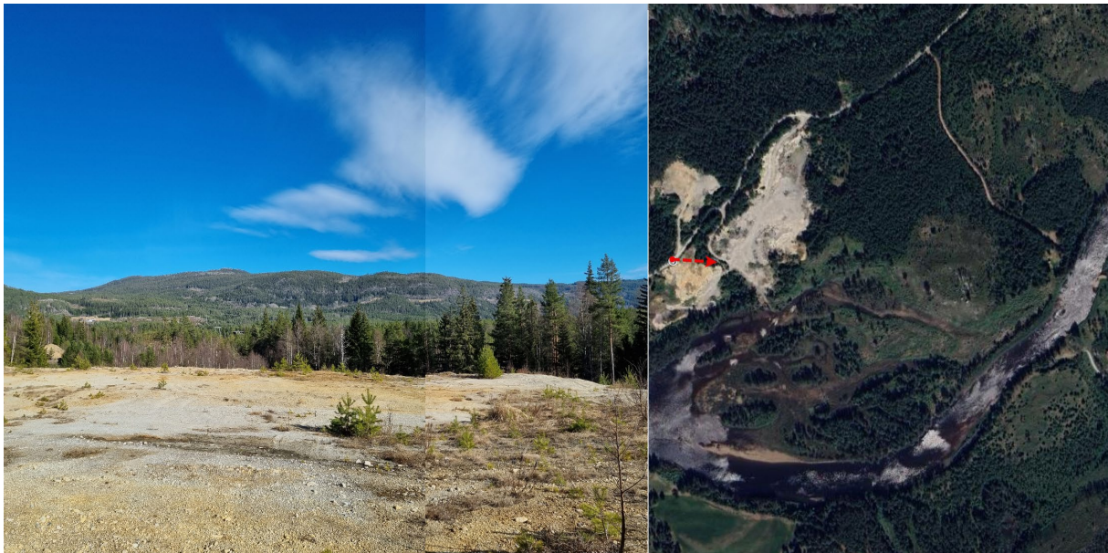
Figur 9: Sett østover i retning kolle der ny mast monteres.
