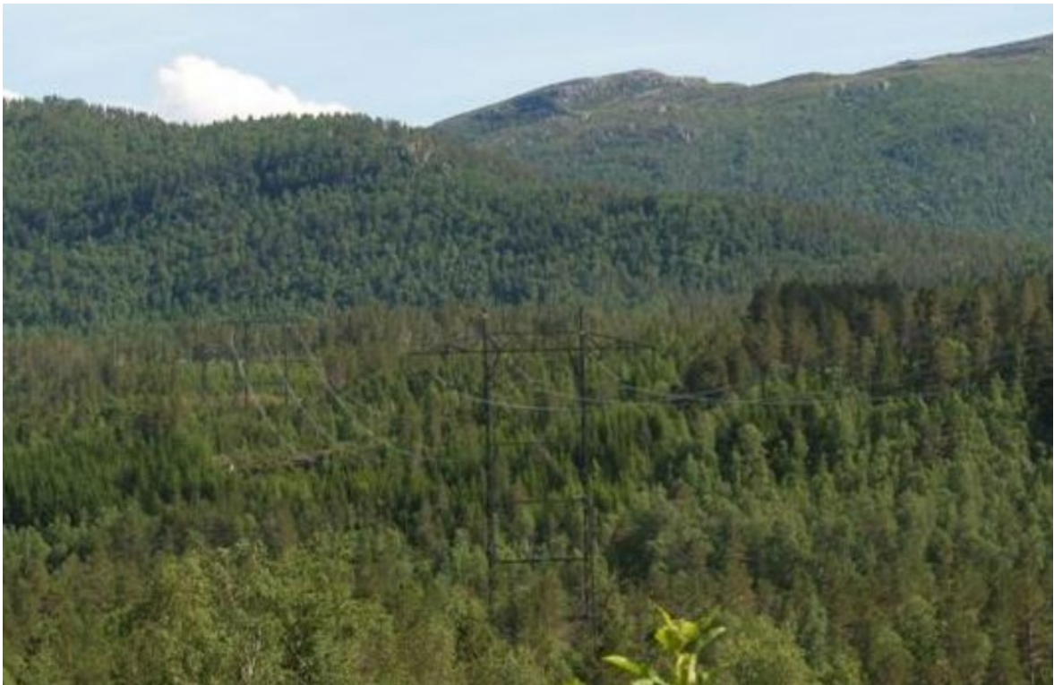
Figur 14-1: Bilde av kamuflert kraftledning. Mastene er grønnmalt, linene er mattede, og isolatorene er av kompositt i stedet for glass.
