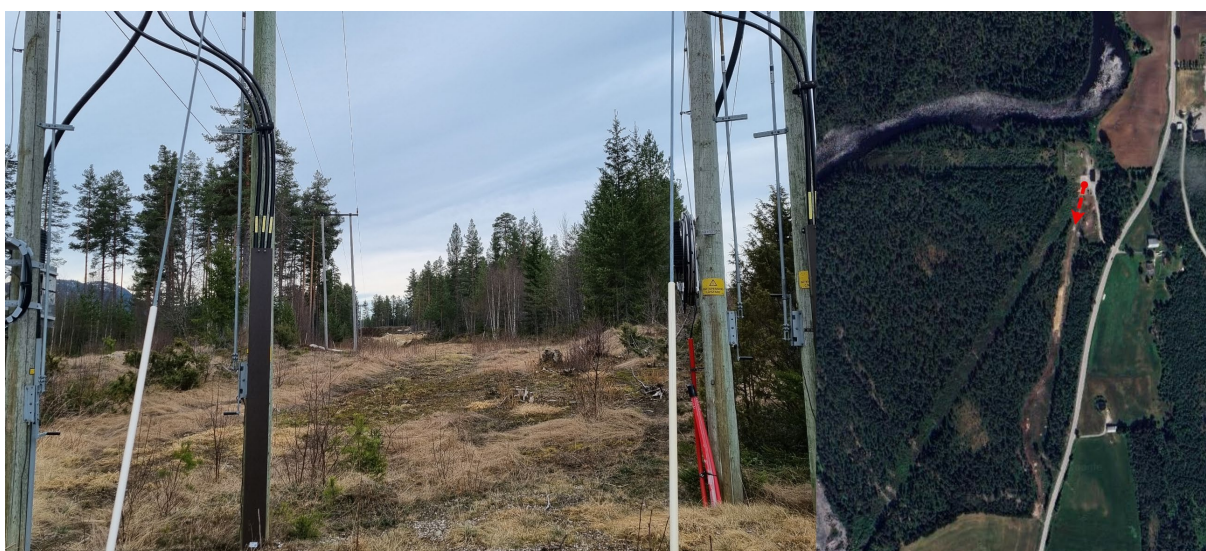
Figur 13: Sett sørover, eksisterende grøftetrasé.
