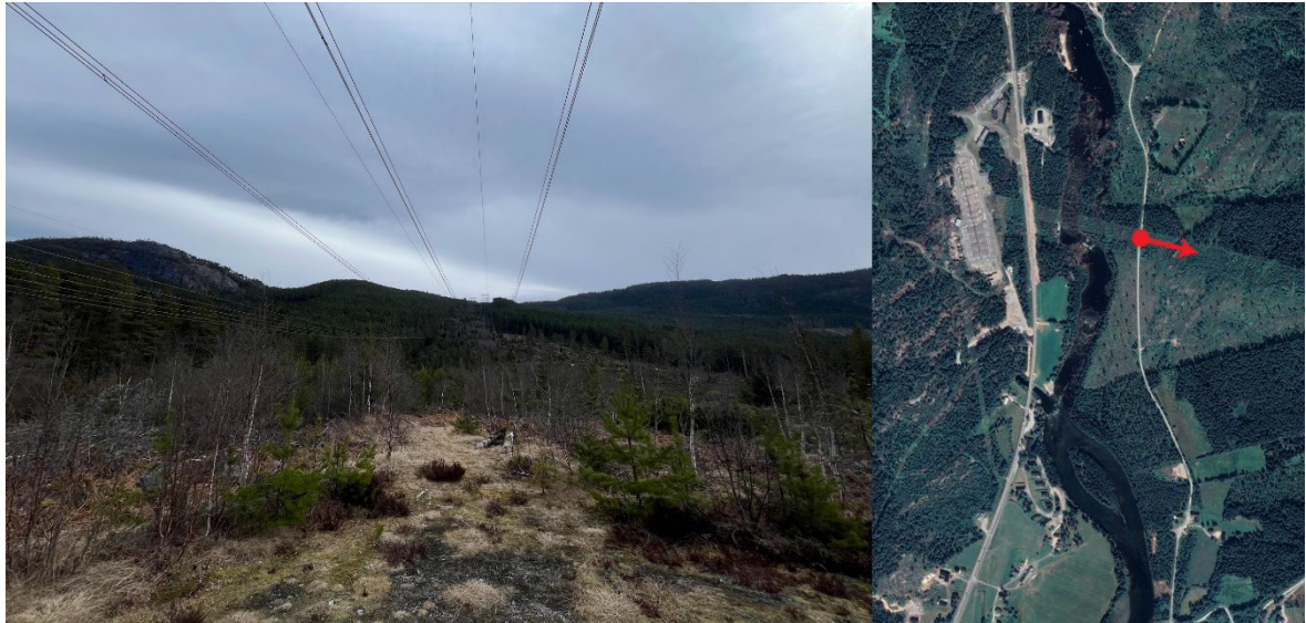
Figur 6-7: Bilde viser eksisterende kraftlinje, sett østover ved Fv333. Vegetasjonen er ryddet langs traséen. Tett på anlegget oppleves landskapet fragmentert. Kilde foto: COWI. Hans Christian Engeland.
