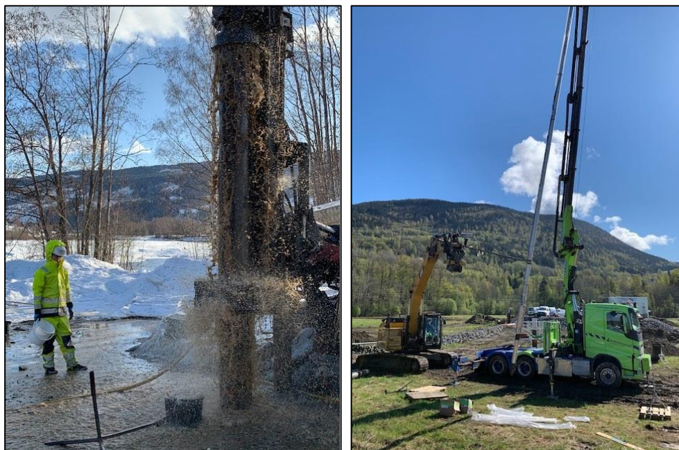
Figur 19. Bilder som viser etableringen av råvannsbrønner på Balbergsøya i mars-mai 2021.
