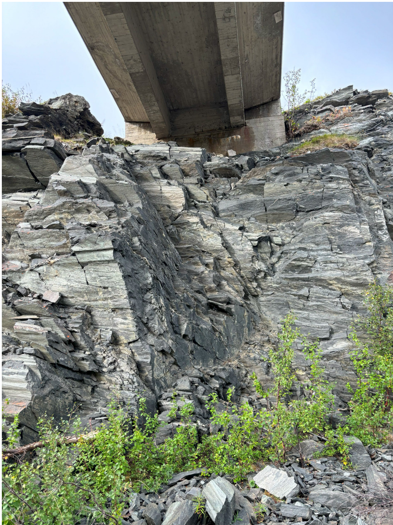
Figur 17: Nordsida av flaumløpet under brua - skifrig og oppsprukken bergmasse.
