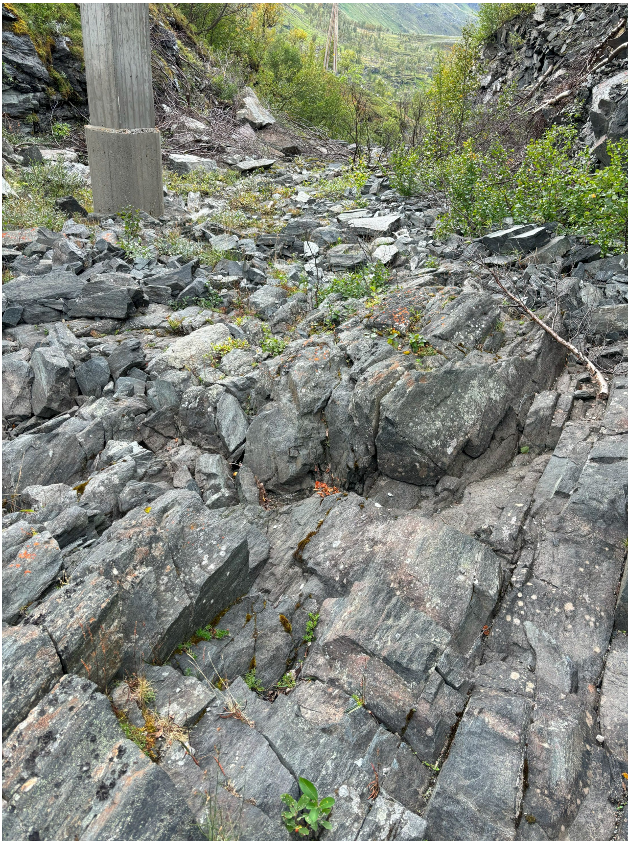
Figur 18: I flaumløpet under brua, sett nedstrøms.
