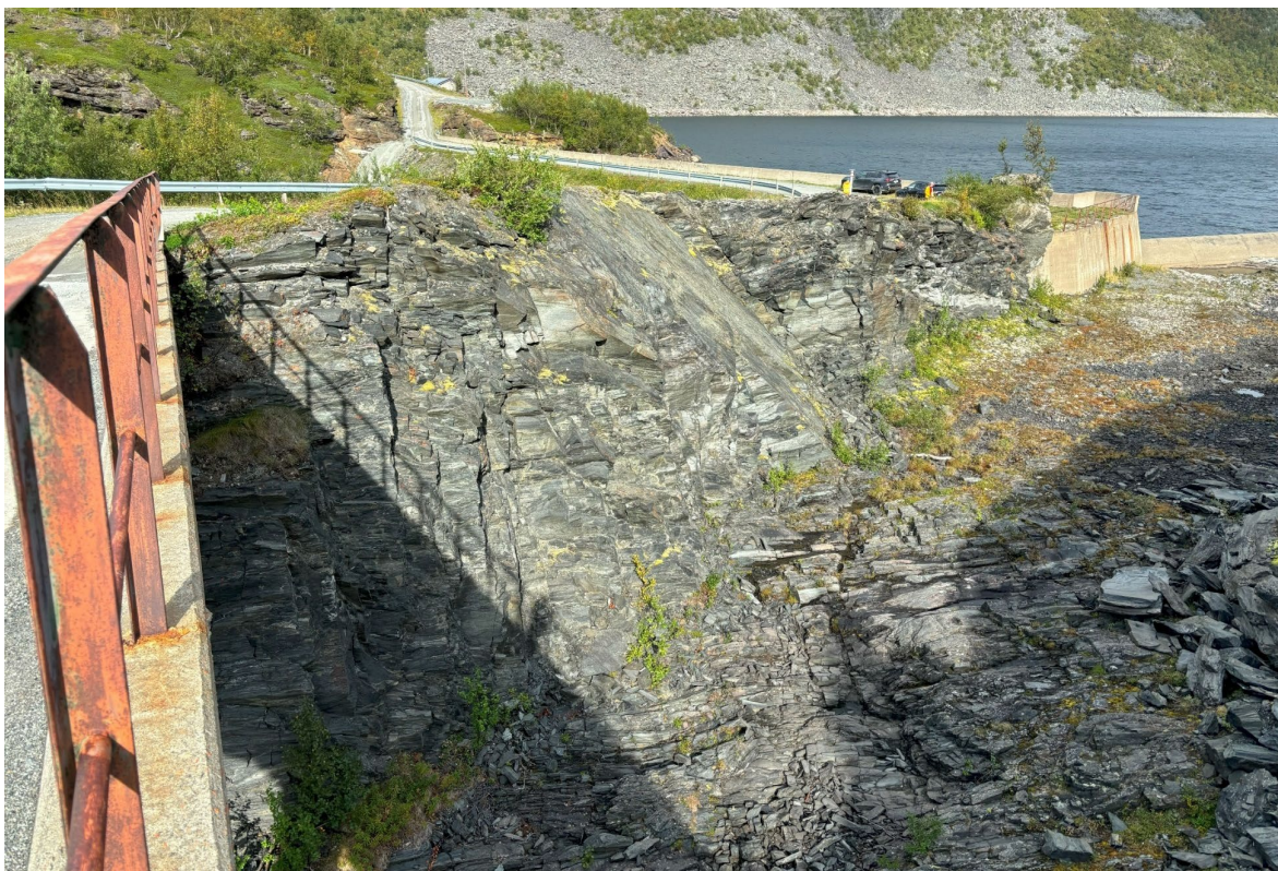
Figur 22: Nordleg bergskrent mellom brua og overløpet.
