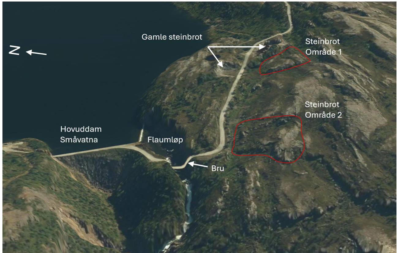
Figur 2: Oversikt over aktuelle uttaksområder for plastringsstein. For skala - fyllingsdammen er ca. 75 m lang.
