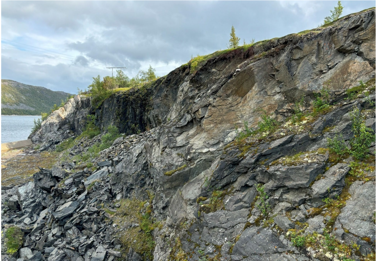
Figur 20: Utrasing frå den sørlege skrenten. Bergmassen er oppsprukken med sprekkeplan med fall ut mot flaumløpet.
