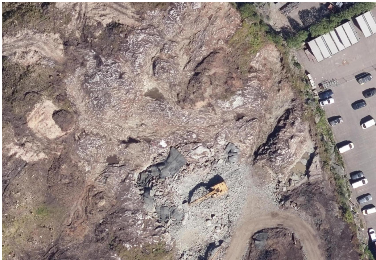
Figur 3-8: Synlig berg i dagen under grunnarbeidene. Flyfoto fra 2019 [5].
