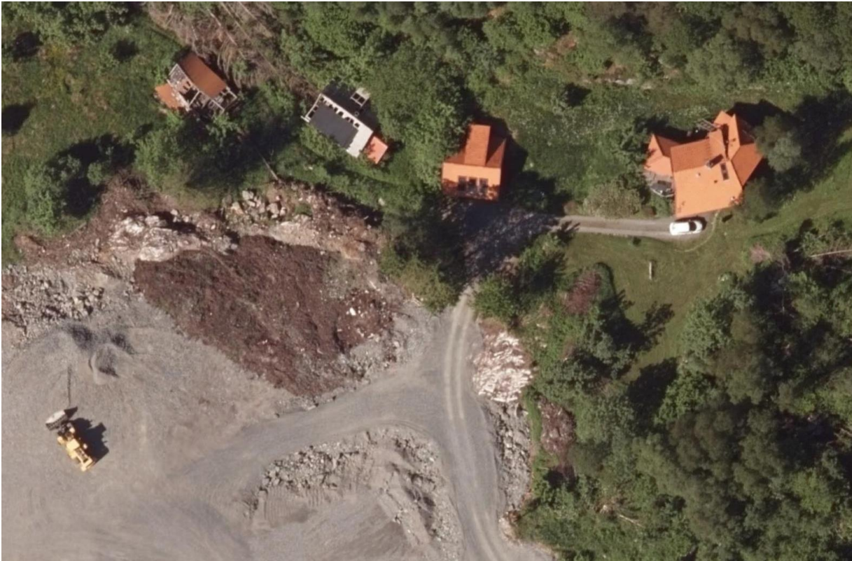
Figur 3-6: Synlig berg i dagen under grunnarbeidene. Flyfoto fra 2014 [5].
