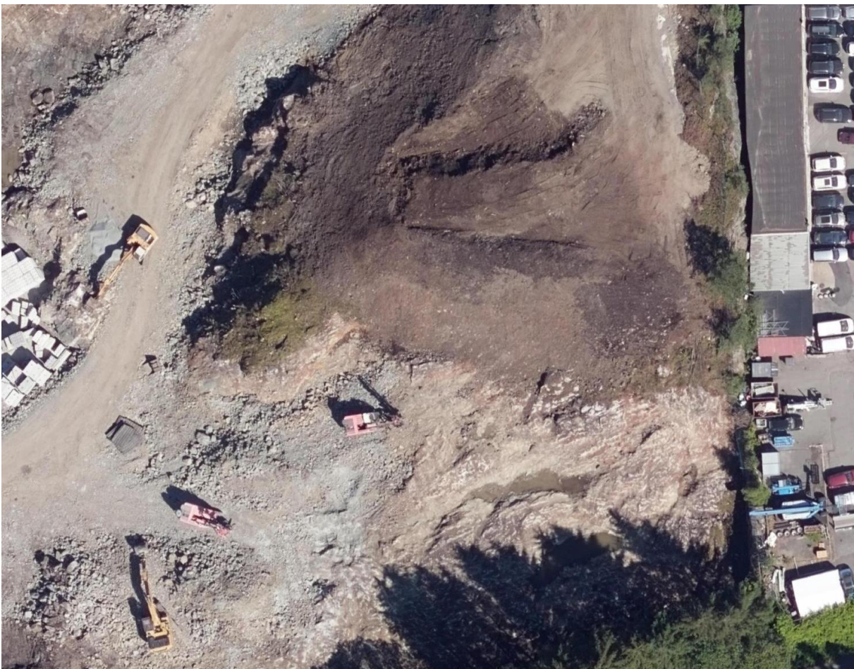
Figur 3-7: Synlig berg i dagen under grunnarbeidene. Flyfoto fra 2019 [5].
