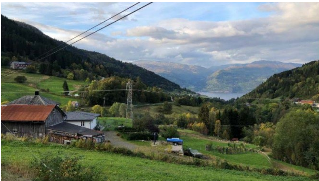
Figur 12 Bildet viser dagens 300 kV kraftledning som ligger tett på bebyggelsen i Åfet/Feios. Kilde: Multiconsult, 2023.
