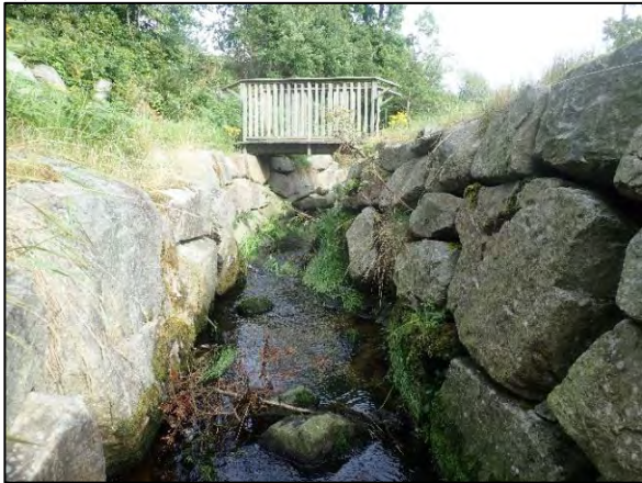
Figur 5.3. Morfologiske inngrep i Riskaåna: A) I segment 13 er det steinforbygninger på begge sider av elveløpet. Ungfisk har skjulmuligheter i forbygningene. B) I segment 16, like oppstrøms bekkelukkingen under Riskaveien, er det kontinuerlige forbygninger på begge sider av elveløpet. Elveløpet er smalt og den morfologiske variasjon dårlig. C) Det er både manglende kantvegetasjon og forbygninger på begge sider av bekken i segment 21. D) Lokal okerutfelling fra dreneringsrør i segment 16.
