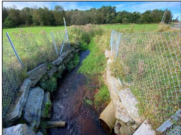
Figur 4.3. Morfologiske inngrep i Hestabekken: A) I segment 4 har bekkeløpet blitt utrettet, og kantvegetasjonen er dårlig. B) På slutten av segment 5 er det forbygninger langs begge sider av bekkeløpet og kantvegetasjonen er manglende. Her ser det også ut til å være et vannuttak vha. en vannpumpe. C) I segment 13 fremstår bekkeløpet svært kanalisert/utrettet. Kantvegetasjonen er tidvis glissen. D) Det er forbygninger langs begge sider av bekkeløpet og glissen kantvegetasjon i segment 15.
