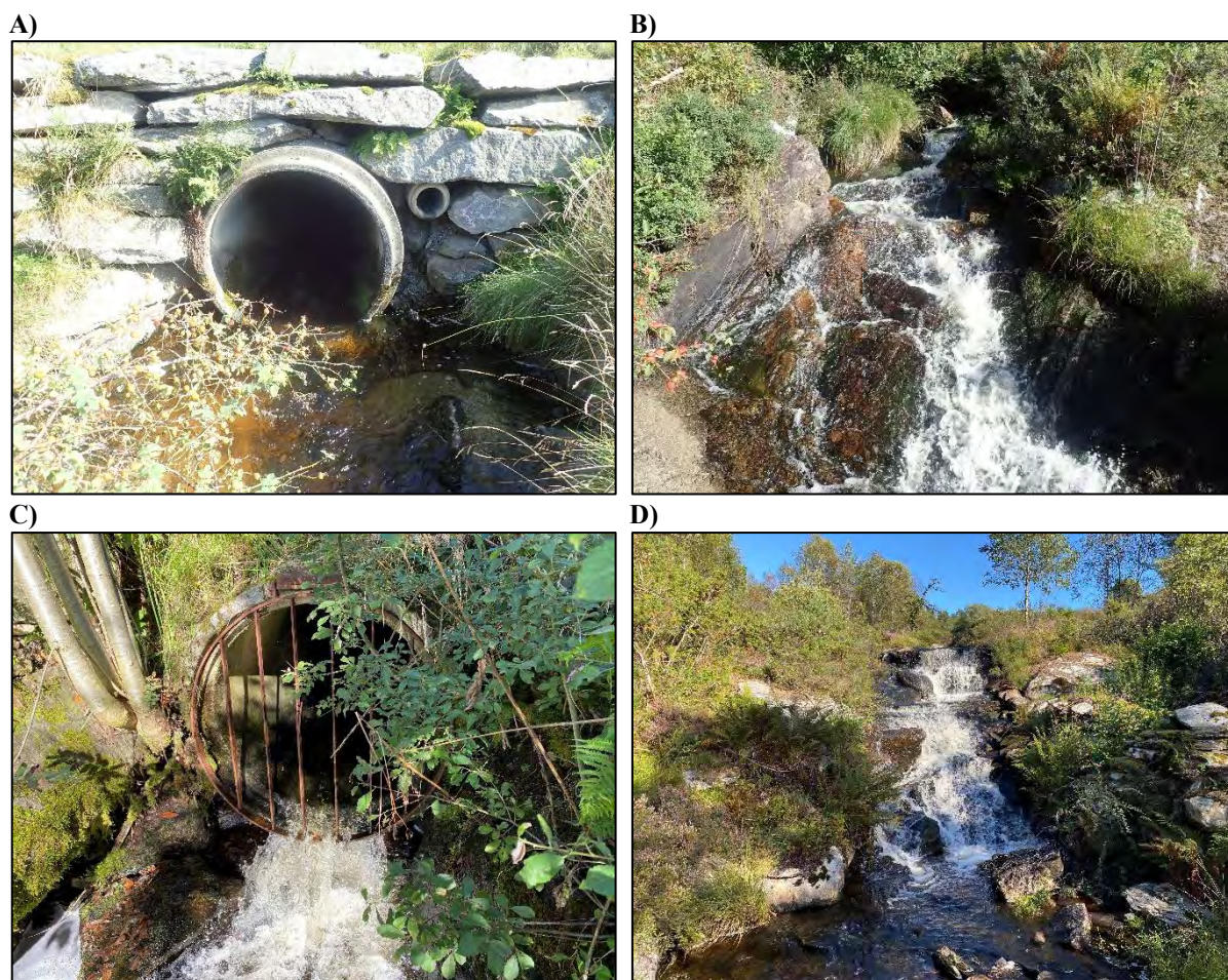
Figur 8.2. Vandringshindre og bekkelukkinger i Eltarvågbekken: A) Røret under Hanasandveien er enkelt å passere for anadrom fisk. B) Temporært vandringshinder i overgangen til segment 9 er krevende å passere ved lav vannføring. Mangel på kulp/høl nedenfor hinderet, til dels grunnet støpt renne i bekkeløpet, vanskeliggjør passasje ytterligere. C) Røret i segment 12 er krevende å passere ettersom røret er forhøyet, kulp nedenfor røret er manglende, og i tillegg har røret rist. D) Naturlig absolutt vandringshinder i segment 13, ca. 500 m oppstrøms osen.
