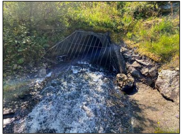
Figur 8.3. Morfologiske inngrep i Eltarvågbekken: A) Manglende kantvegetasjon langs ene siden av bekkeløpet i segment 8. B) I segment 8 er det en støpt renne i bekkeløpet. C) I segment 10 er det forbygninger langs bekkeløpet og glissen kantvegetasjon. D) I segment 13 er elvebunnen plastret like ovenfor innløpet til røret. Legg merke til at det også er en metallrist foran røret.
