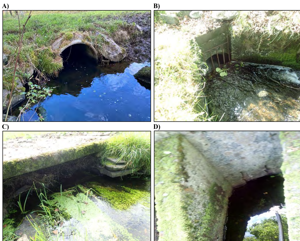
Figur 9.4. Bekkelukkinger i Nådebekken: A) Røret mellom segment 3 og 4 har enkel passasje for fisk.. B) I segment 10 er det en rist foran innløpet til den lange bekkelukkingen som kan være problematisk å forsere for stor fisk. C) I segment 15 er innløpet til bekkelukkingen nesten tettet igjen av drivved. D) Innløpet til røret under veien i segment 18 er demmet opp og passasjen er svært trang for fisk.
