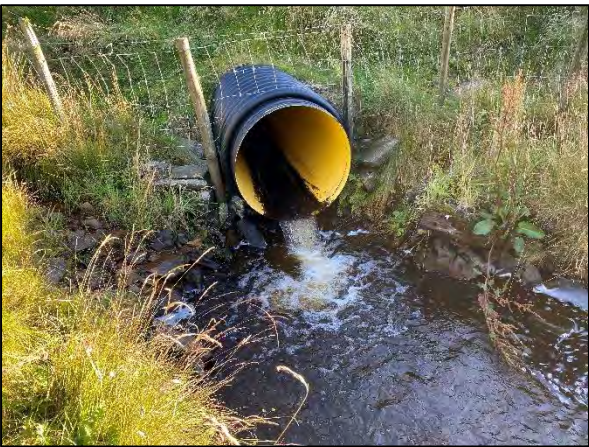
Figur 7.2. Vandringshindre og bekkelukkinger i Sørbøbekken: A) Det nederste temporære vandringshinderet, i segment 3, er vanskelig å passere ved lav vannføring. B) I segment 4 går det et gjerde over bekken som har ansamlet mye drivved. Per i dag utgjør det et kunstig, absolutt vandringshinder for anadrom fisk. C) Plastrøret i segment 17 er forhøyet og kan dermed være krevende å forsere for liten fisk. Ellers er kulpen, like nedenfor røret, til hjelp slik at fisk kan hoppe opp og inn i røret. D) Øverst i Sørbøbekken, i segment 23, er det et svært lang rør under et jorde. Røret utgjør et kunstig, absolutt vandringshinder.
