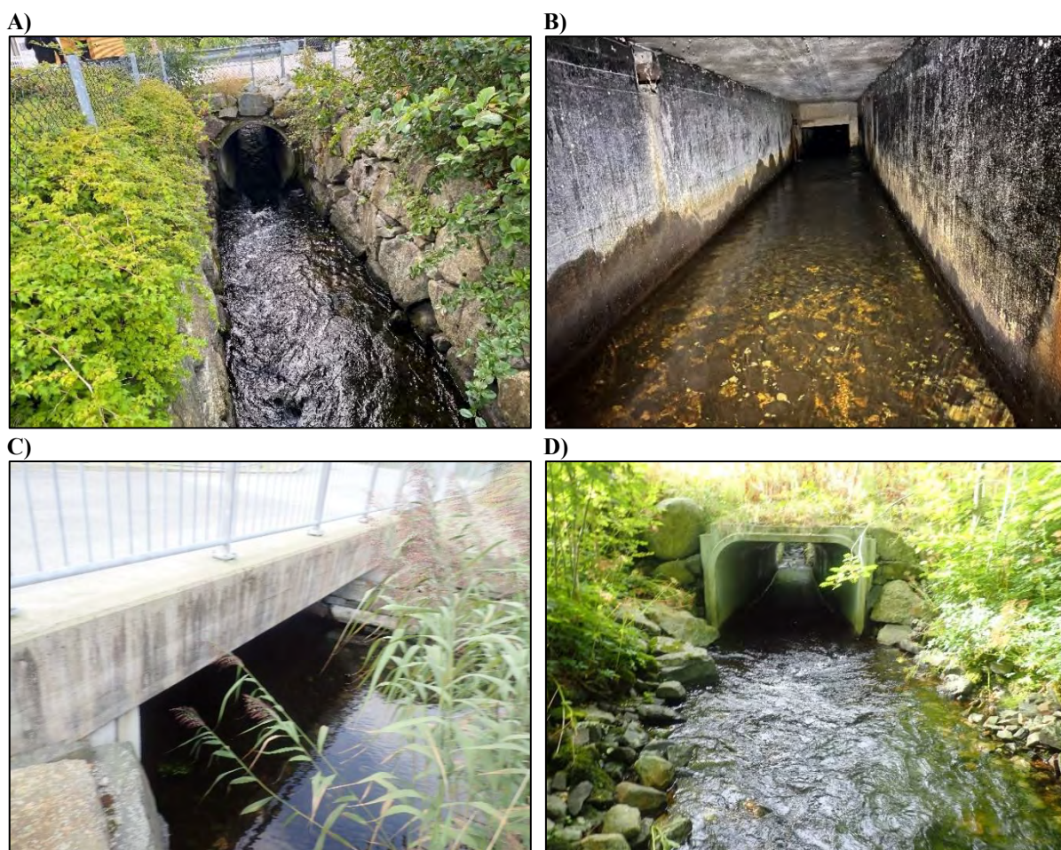
Figur 6.3. Bekkelukkinger i Frøylandsvassdraget: A) Røret i overgangen til segment 2 er ~12 m langt og er enkelt å passere for anadrom fisk. B) Fra segment 4 er det betongkulvert under bebyggelsen. Bunnen er plastret, men til dels tildekket med naturlig substrat. Etter om lag 40 m går kulverten over i et rør som fortsetter videre opp mot demningen. C) Kulverten i segment 5 har naturlig bunns substrat og fisk kan enkelt passere. D) Kulverten mellom segment 17 og 18 er enkel å passere, men har plastret betongbunn uten naturlig bunns substrat.
