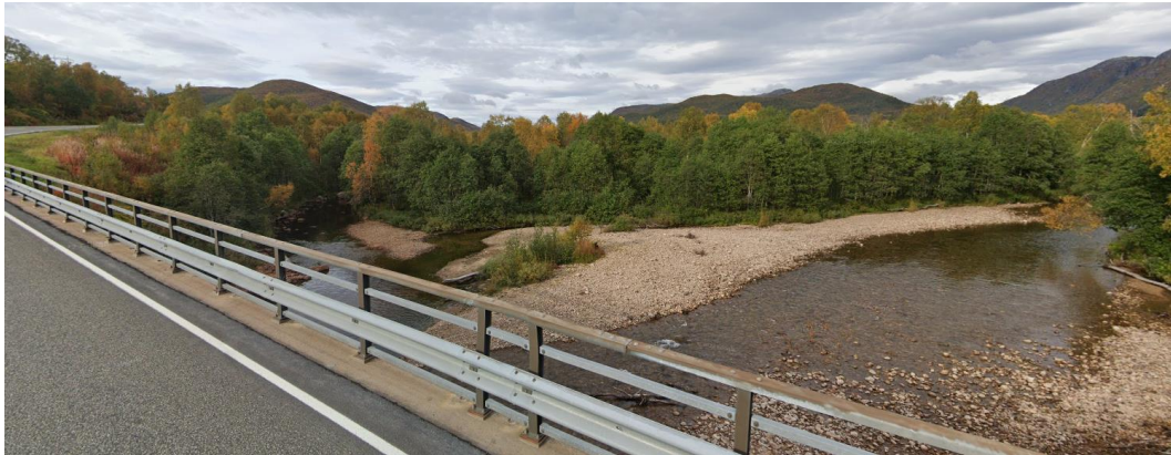
Figur 4: Bildet av Heggedalselva er tatt fra eksisterende bru nordover. Kilde: Google Streetview. Anleggsområdet for pilarer til ny bru sees midt i bildet.
