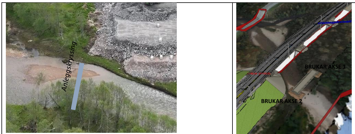
Figur 6: Kryssing av anleggsvei over Heggedalselva.
