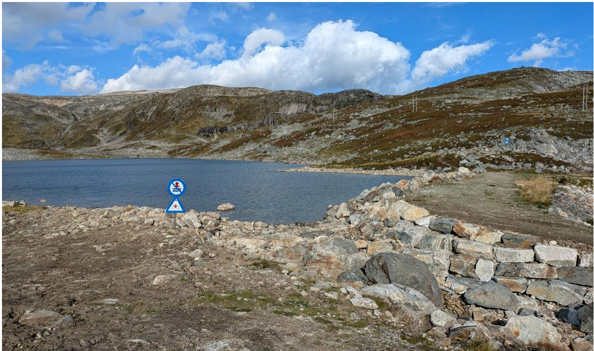
Figur 5-1. Demning Nedre Svarthammervatn.
