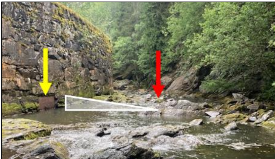
Figur 3-14: Planlagt inntaksløsning. Det skal bygges en liten terskel som fører vann inn i luka. Terskelen er en skisse, må kontrollmåles om terskel skal gå over hele elveløpet. Foto: Trond Varslot.
