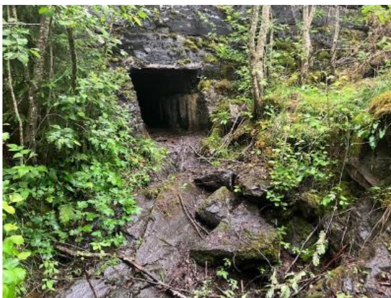
Figur 2-5: Inntaksområde, sørside av mur og utløp av eksisterende åpning i mur
