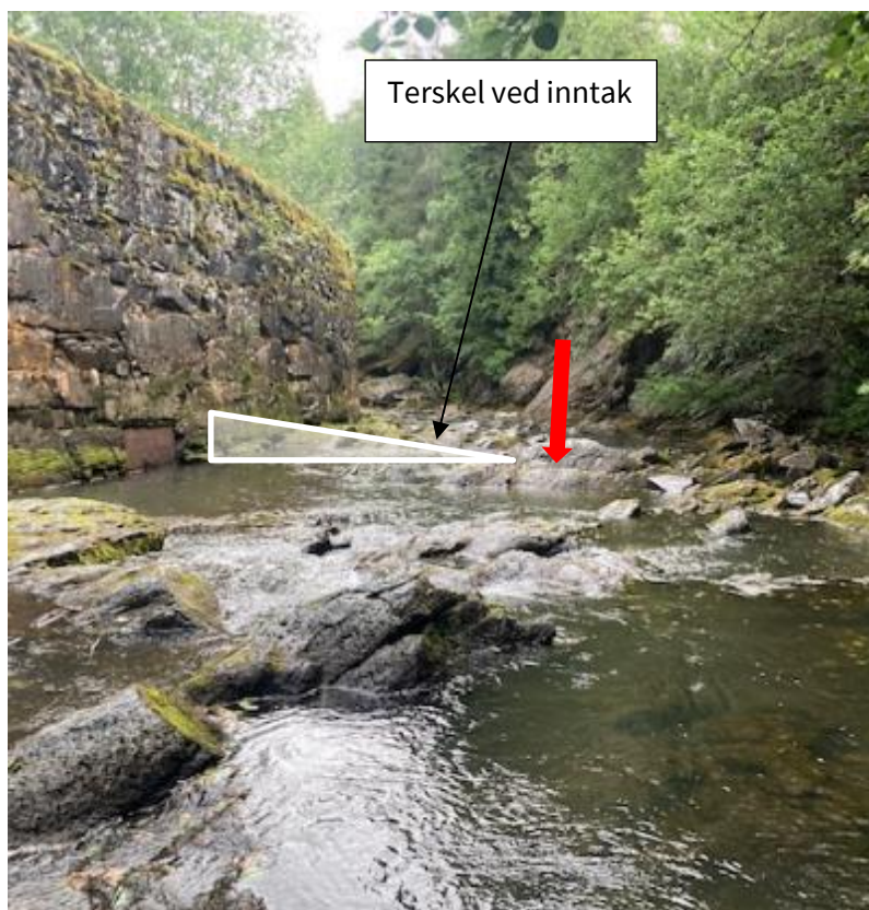
Figur 2-4: Inntaksområde, på nordside av mur. Sett medstrøms.
