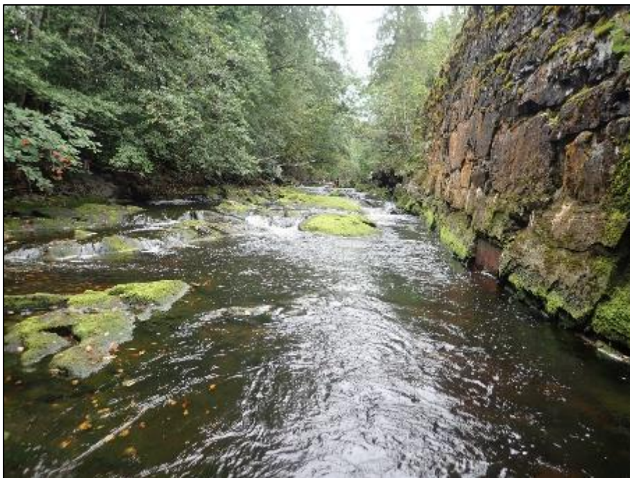
Figur 3-13: Inntaket er planlagt gjennom luken som kan ses nederst på muren. Foto: Sweco.
