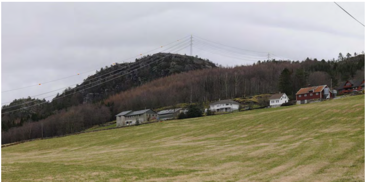
Figur 4-9 Ny 132 kV-ledning ved Risanger, alt. 1.2 b, utsnitt av panorama (se vedlegg 4). Traseen er trukket nordover og høyere i terrenget for å unngå ryddegate gjennom plantefelt ved Risanger. For å heve spennet over plantefeltet kreves en mast på Ravnafjellet. Dette gir et langt og høyt spenn som må merkes med flymarkører på topplina. Masten kreves malt i signalgul farge, eller med rød og hvite striper.
