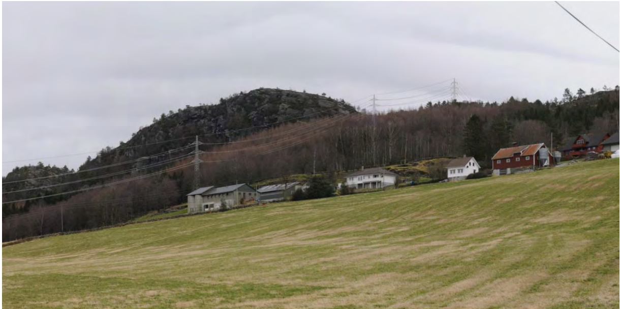
Figur 4-8 Ny 132 kV-ledning ved Risanger alt. 1.2 a, utsnitt av panorama (se vedlegg 4). Løsningen er i tråd med konsesjonsgitt trase ved Risanger gård. Det bemerkes at rydebeltet ikke er lagt inn i visualiseringen.
