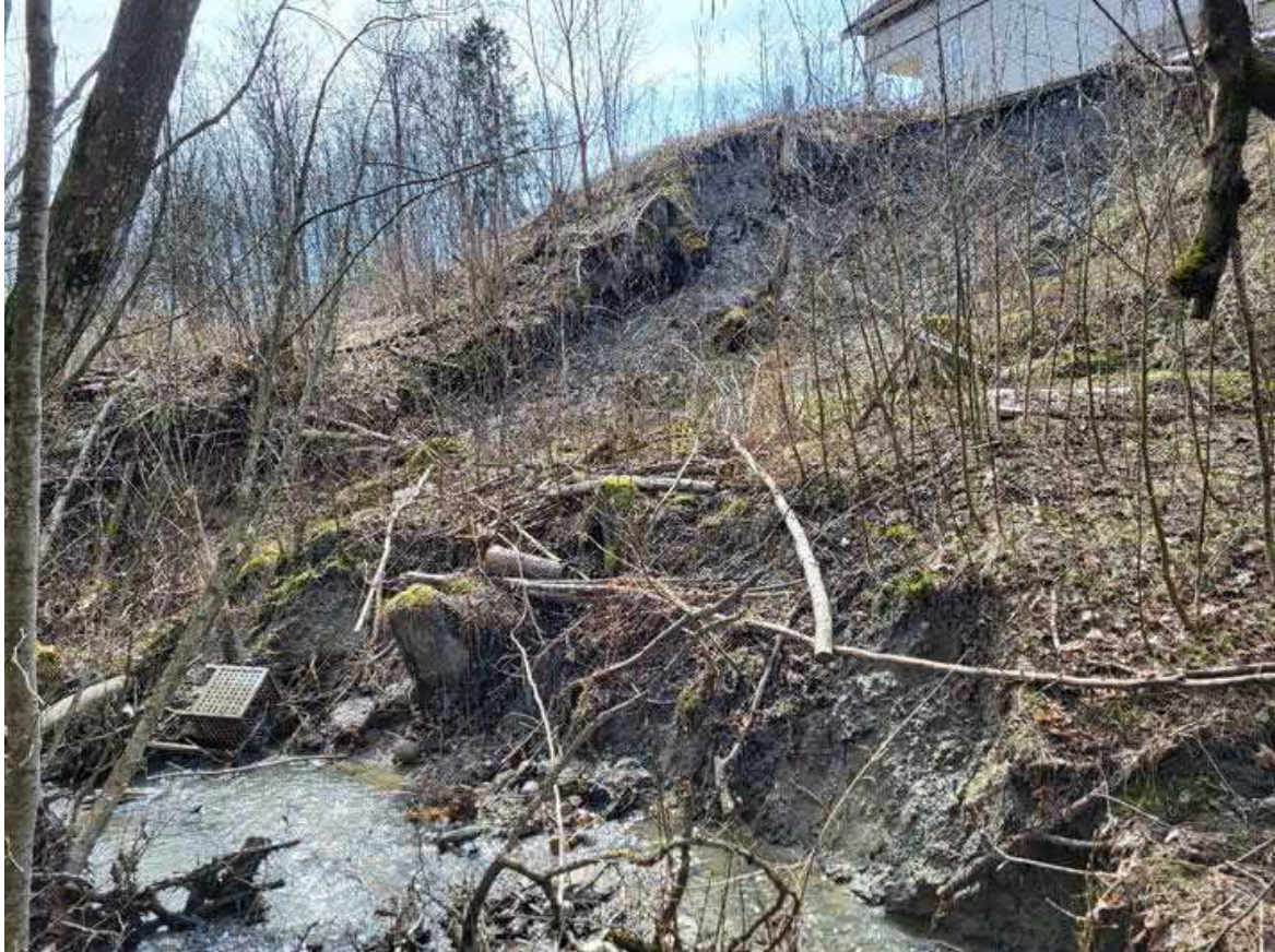
Figur 4 Kraftig erosjon og utglidning ved Landfallbakken 3.
