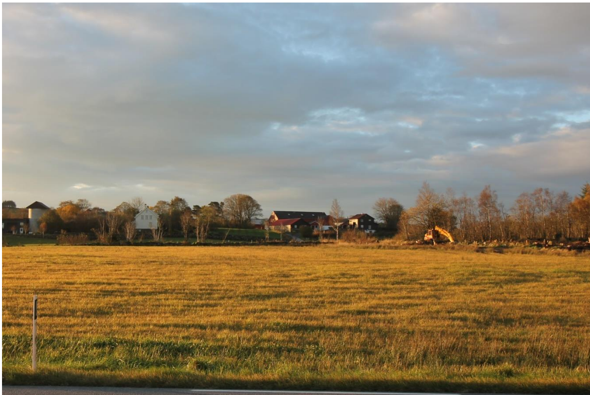
Figur 180. SEFRAK 11190213011, driftsbygning. Mot sør.
