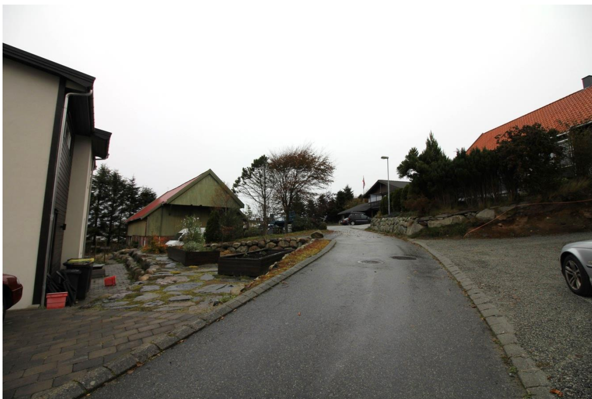
Figur 47. SEFRAK 11200005128, løe i byggjefelt. Mot nord.
