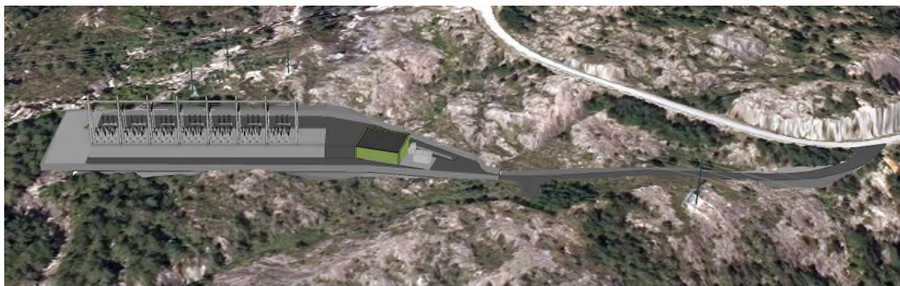
Figur 1 Helmikstøl transformatorstasjon sett fra sør
