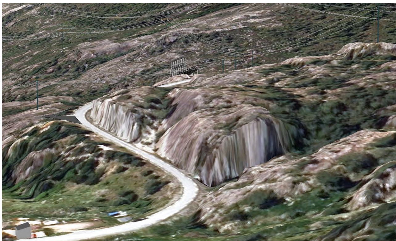
Figur 6 Helmikstøl transformatorstasjon sett fra Helmikstøl gård
