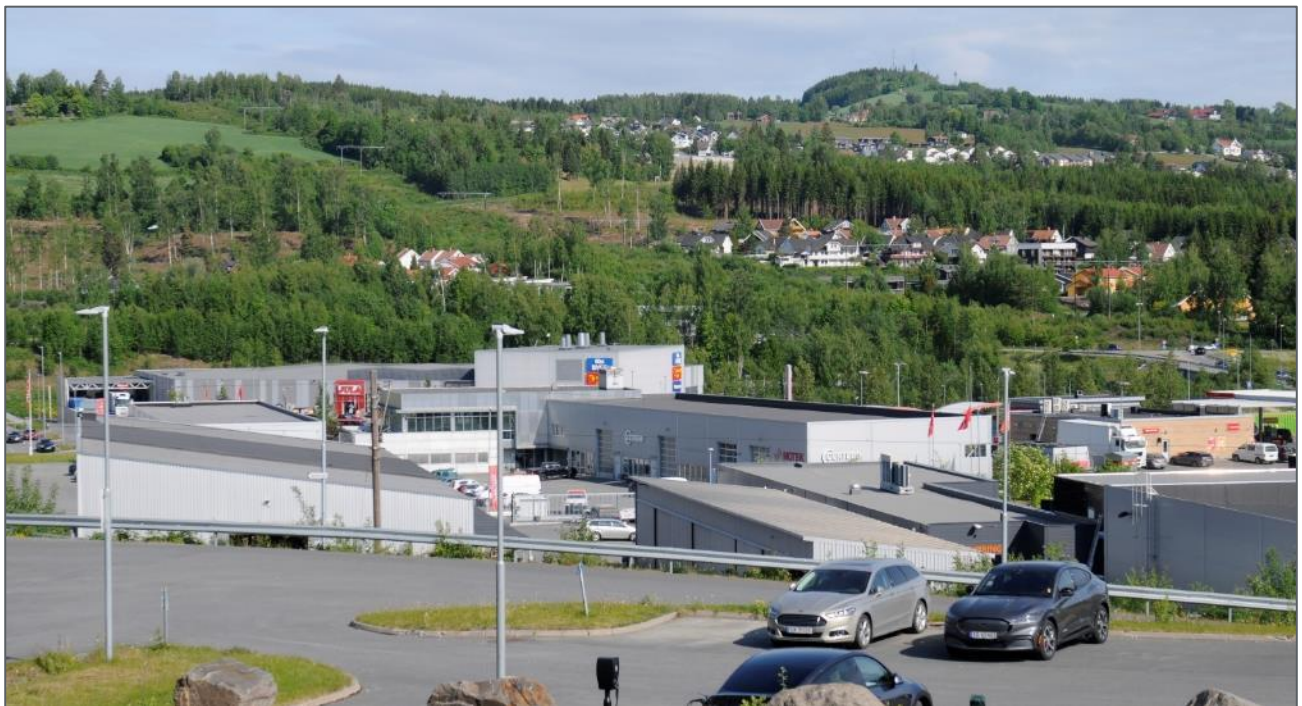
Figur 4-19: Bildet tatt fra Gjøvik energisentral med utsyn mot Brusvehagen og dagens ledning som går mellom bebyggelsen.
