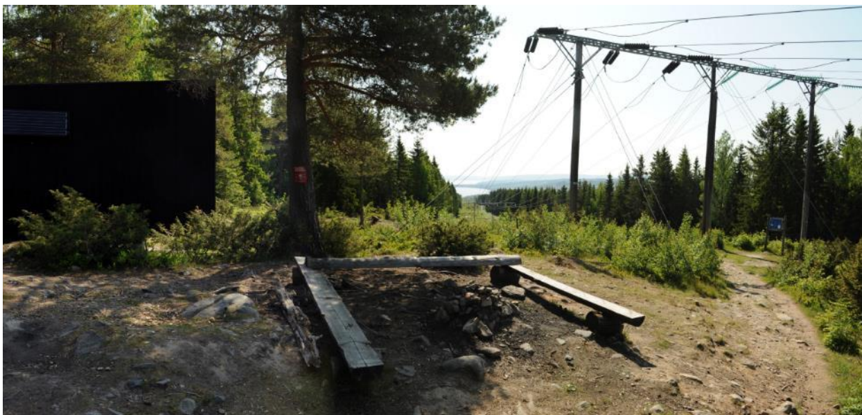
Figur 5-49 Dagens ledning ved Byhaugen i dag
