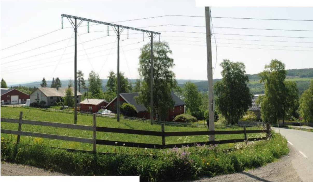
Figur 5-45 Dagens ledning ved Nedre Skjervum
