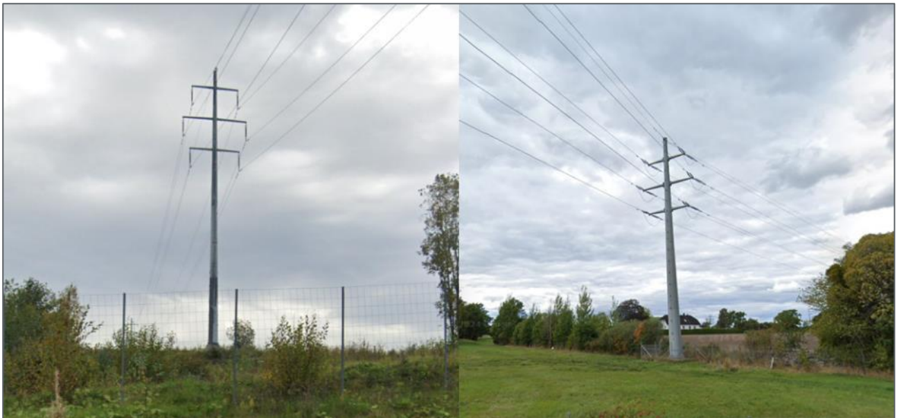
Figur 5-30: Eksempel på vertikalopphengt dobbeltkursmast (høyre bilde viser en noe kraftigere vinkelmast). Hentet fra google streetview (Spydeberg-Tunby til venstre og Halmstad-Råde til høyre).
