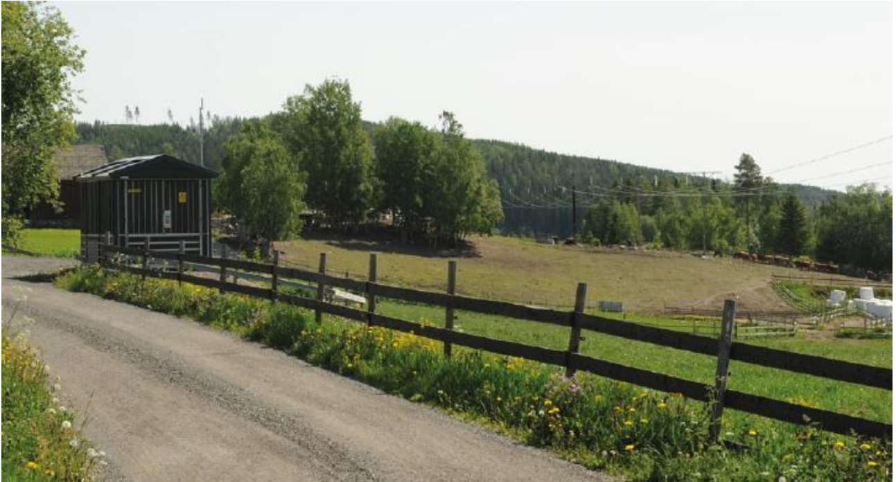
Figur 5-43 Dagens ledning ved Nedre Skjervum
