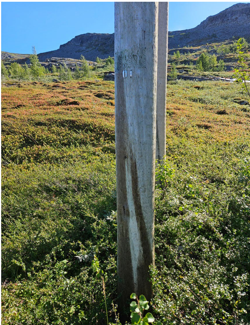
Figur 7: Mastefot på eksisterende 22 kV linje hvor kabel tilkoples.
