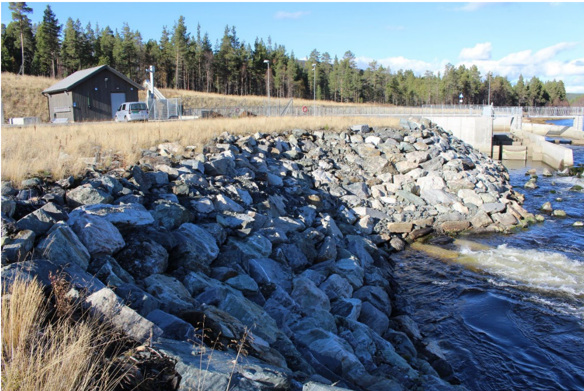
Figur 8. Skråningen mot elva er erosjonssikret. Erosjonssikringen må fjernes midlertidig mens det nye 400 mm røret legges ned. Reetablering av erosjonssikringen inngår i tiltaket.
