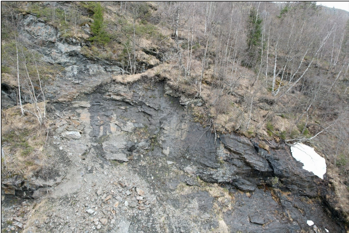
Figur 12: Tydelig avløste blokker på mer enn 100 m 3 i toppen av ene løснеområdet for jordskredet i 2023 under ekstremværet Hans.
