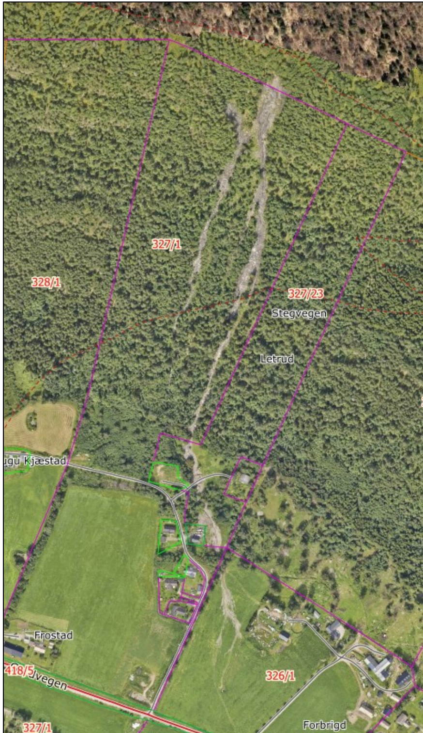
Figur 7: Flyfoto fra 2023-08-18 som viser skredhendelsen under Hans. Nord er orientert opp i bildet
