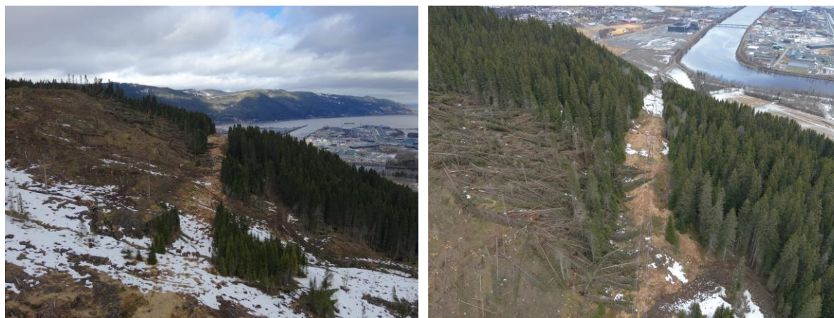
Figur 2-11: Bilder tatt av Tensio TS av eksisterende 66 kV trasé ved Gjølmesli.
