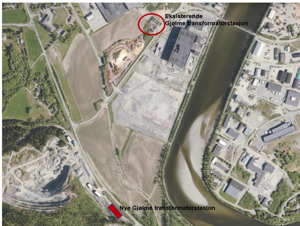
Figur 2-3: Tensio TS omsøker ny Gjølme transformatorstasjoner på eiendom 257/1 i sandtaket ved E39.
