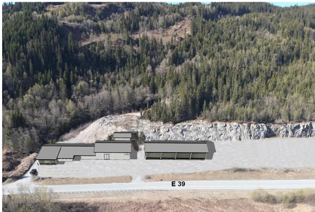
Figur 2-4: Nye Gjølme transformatorstasjon i steinbruddet ved E39, sett fra nordøst.
