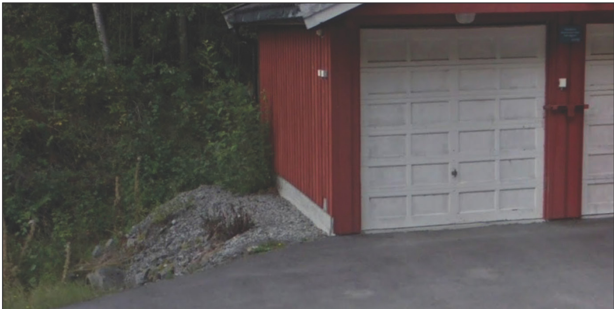
Figur 7 eksisterende garasjebygg ved Kaggefoss kraftverk langs Kaggefossveien er lagt over Sjulselva. OPI-kanal (50 kV Gravfoss-Kaggefoss) vil etableres over elva på samme måte ved at bekken legges i rør og OPI-kanalen legges over rørene.
