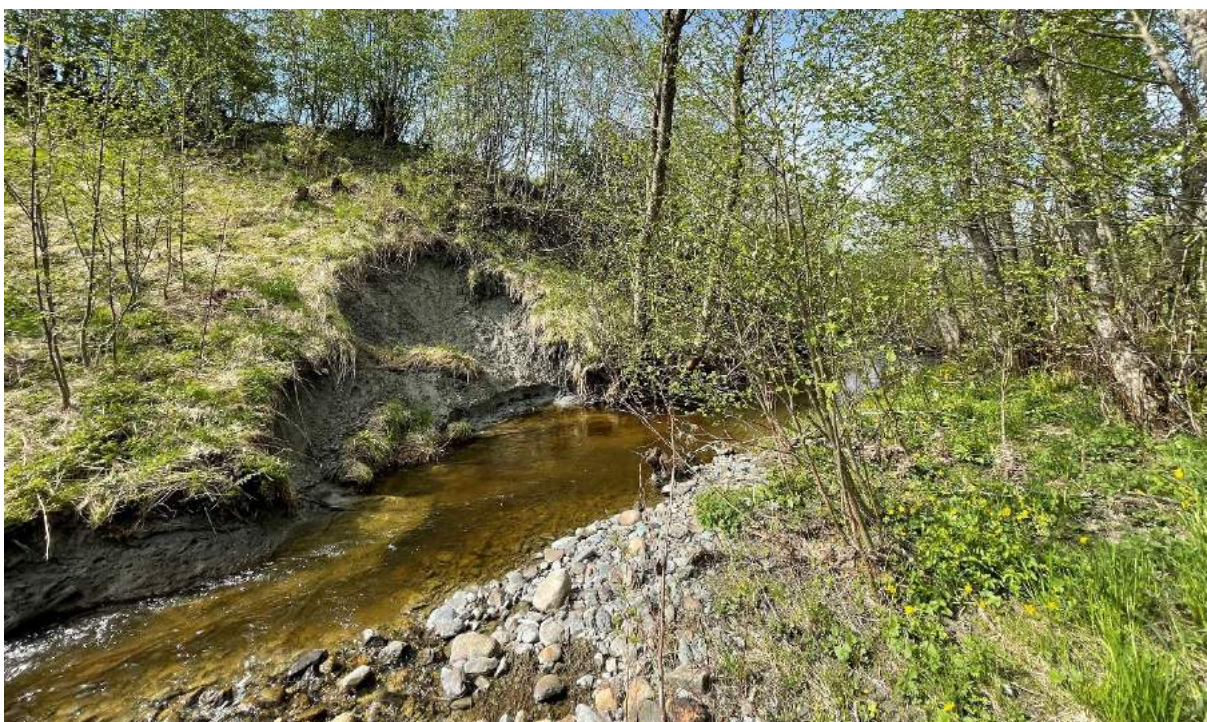
Figur 1.17 Lokal overflateglidning (bredde og lengde < 10 m og dybde rundt 1 m). Enkelte trer står på skakke. Bunn og til dels sider fremstår som «naturlig erosjonssikret» med stein og vegetasjon, men ved stor vannføring spises det av skråningsfoten (bestående av leire) på sørlig side. Erosjon klassifiseres som «noe erosjon» (poengscore 2). Bilde: IMG_1437, Per Mo, 19.05.2022, bilde tatt mot sør-vest.
