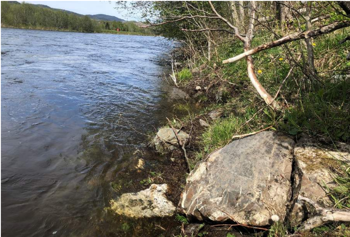
Figur 1.3 Eksisterende plastring av spengstein og moreneblokk langs Gaula. Bilde: IMG_4970, Jakob Bitsch Jensen, 19.05.2022, bilde tatt mot nord.
