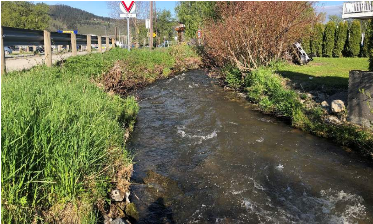
Figur 1.27 Sider i noe grad erosjonssikret med vegetasjon og div. stein/betongblokk. Bunn i noe grad naturlig erosjonssikret med stein/grus. Vann fremstår litt misfarget. Erosjon klassifiseres som «lite erosjon» (poengscore 1). Bilde: IMG_4730, Jakob Bitsch Jensen, 19.05.2022, bilde tatt mot vest.
