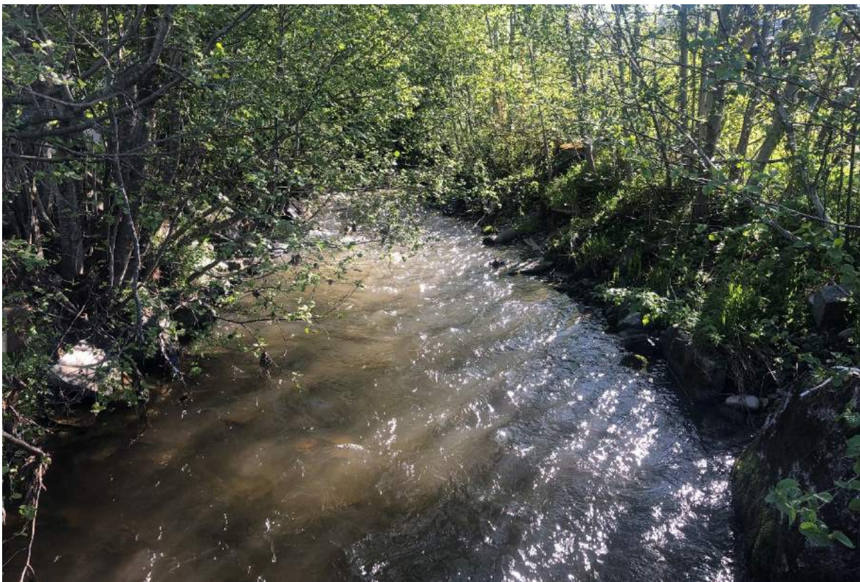
Figur 1.24 Sider i noe grad erosjonssikret med vegetasjon (i hovedsak pil) og div. stein/betongblokk. Bunn i noe grad naturlig erosjonssikret med stein/grus. Vann fremstår litt misfarget. Erosjon klassifiseres som «lite erosjon» (poengscore 1). Bilde: IMG_4735, Jakob Bitsch Jensen, 19.05.2022, bilde tatt mot øst.
