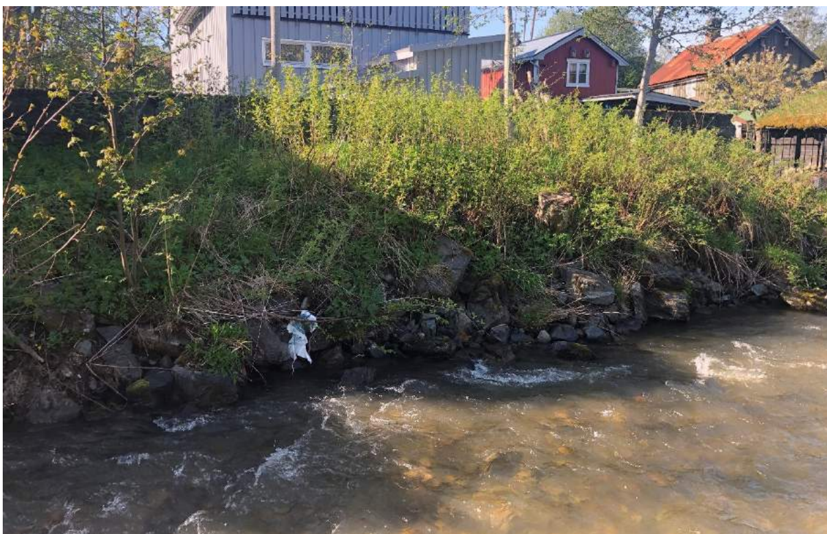
Figur 1.30. Side i noe grad erosjonssikret med vegetasjon og stein/betongblokk. Bunn i noe grad naturlig erosjonssikret med stein/grus. Vann fremstår litt misfarget. Erosjon klassifiseres som «lite erosjon» (poengscore 1). Bilde: IMG_4752, Jakob Bitsch Jensen, 19.05.2022, bilde tatt mot sør.
