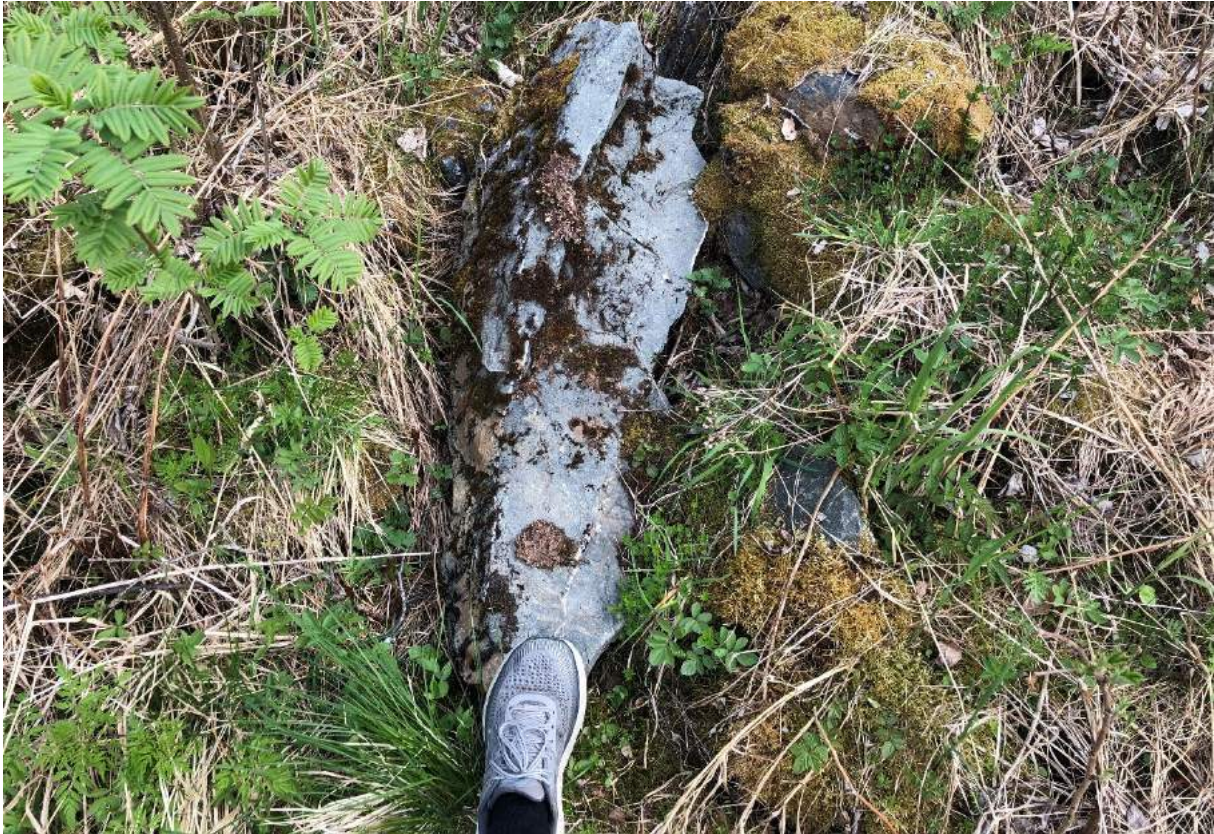
Figur 1.5 Eksisterende gjengrodd plastring av sprengstein oppover i skråningen langs Gaula. Fot størrelse 43 som målestokk. Bilde: IMG_4980, Jakob Bitsch Jensen, 19.05.2022, bilde tatt oppover i skråningen mot øst.
