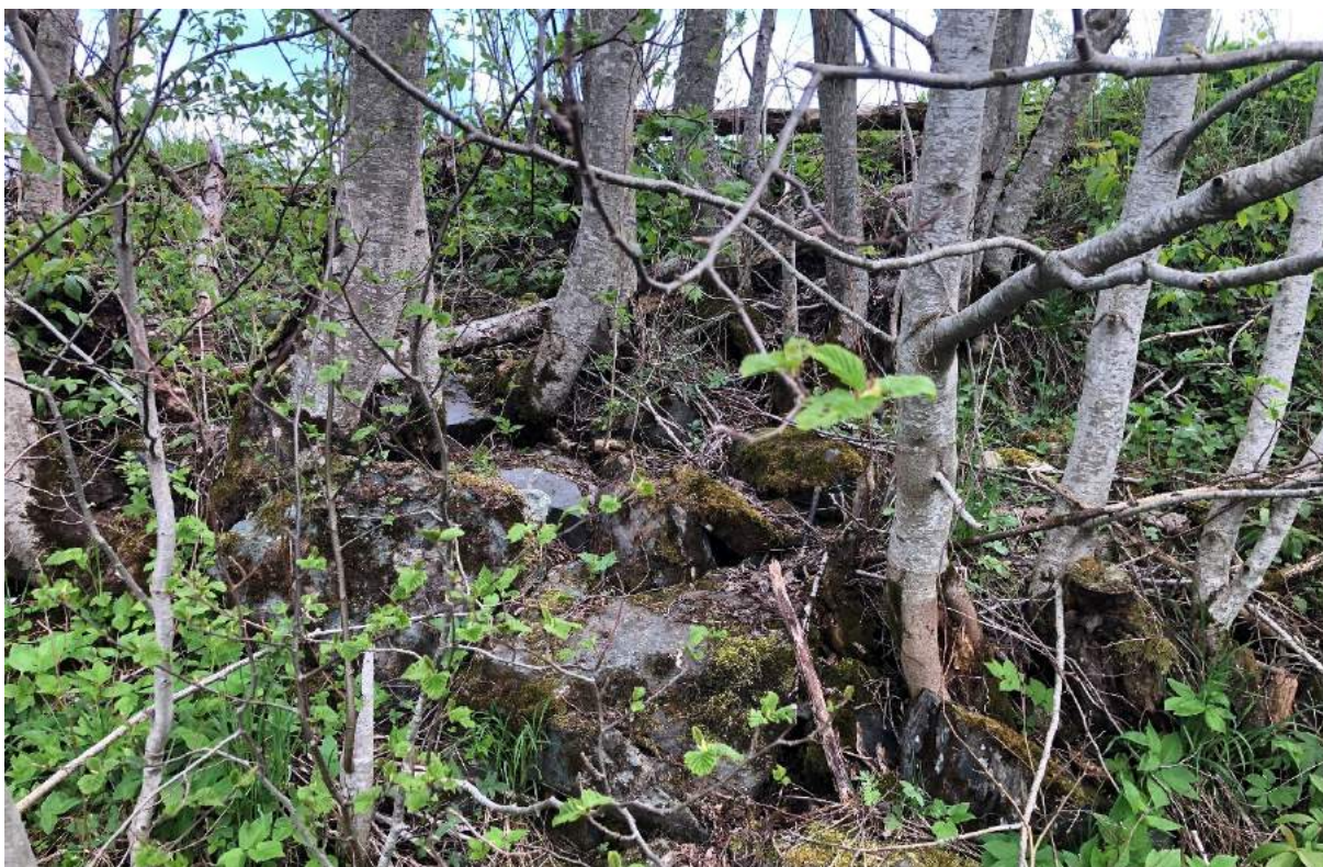
Figur 1.7 Eksisterende gjengrodd plastring av sprengstein og moreneblokk oppover i skråningen langs Gaula. Bilde: IMG_5005, Jakob Bitsch Jensen, 19.05.2022, bilde tatt oppover i skråningen mot øst.
