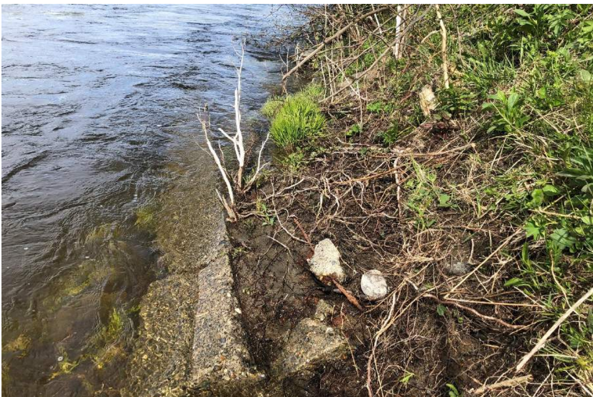
Figur 1.4 Eksisterende erosjonssikring med betongblokk langs Gaula. Bilde: IMG_4974, Jakob Bitsch Jensen, 19.05.2022, bilde tatt mot nord.
