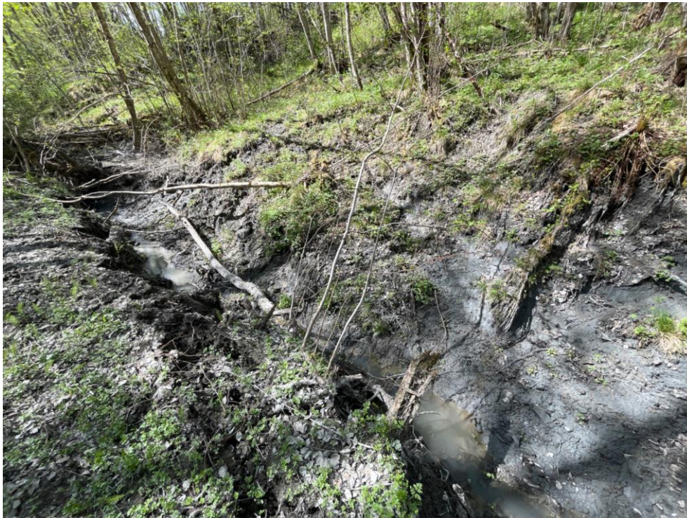
Figur 2-105: Erosjon i bekk i Profil Dragvoll 1
