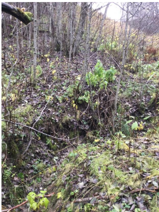
Figur 2-3: Profil 1. Møt øst. Noe grunnvannserosjon.
