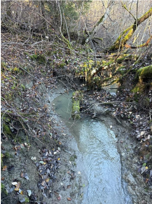
Figur 2-84: Profil 9. Mot nordvest. Flere større utglidninger. Høy hastighet på bekk. Kraftig erosjon vurdert fra tidligere.
