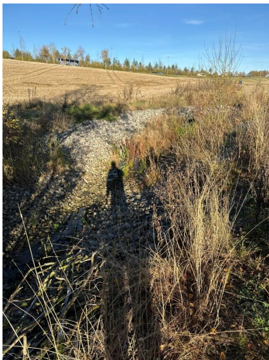
Figur 2-19: Profil 3. Mot nordvest. Steinsatt bekkeutløp. Lite erosjon.
