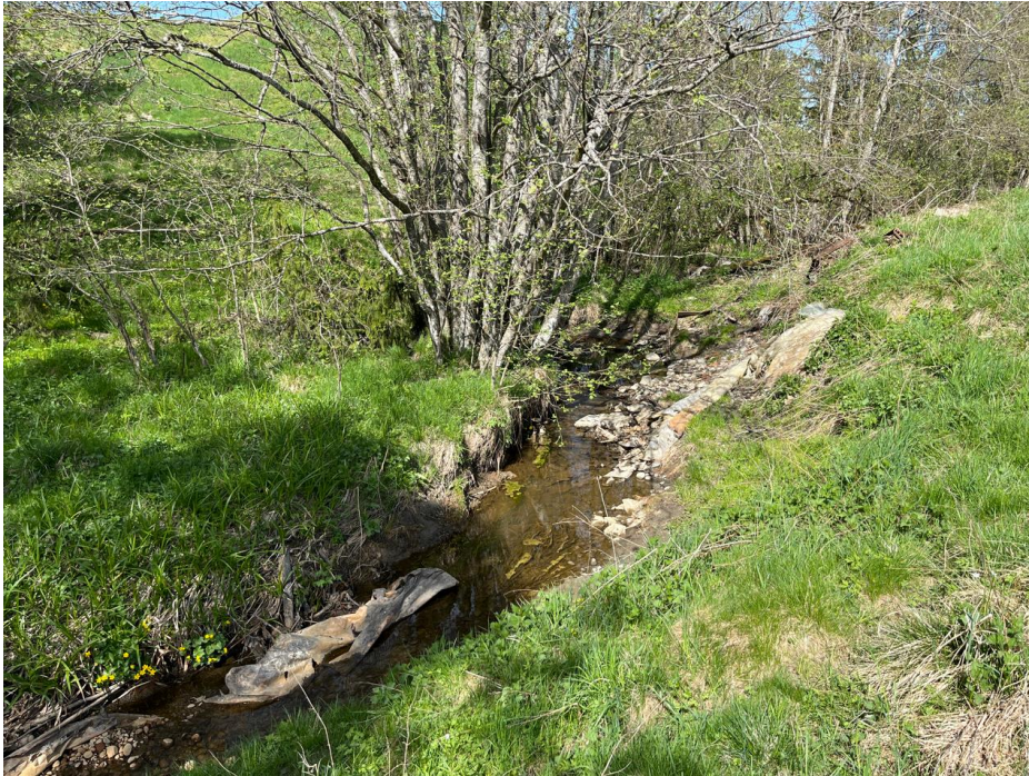
Figur 2-23: Bekk sett fra bildepunkt A. Litt erosjon
