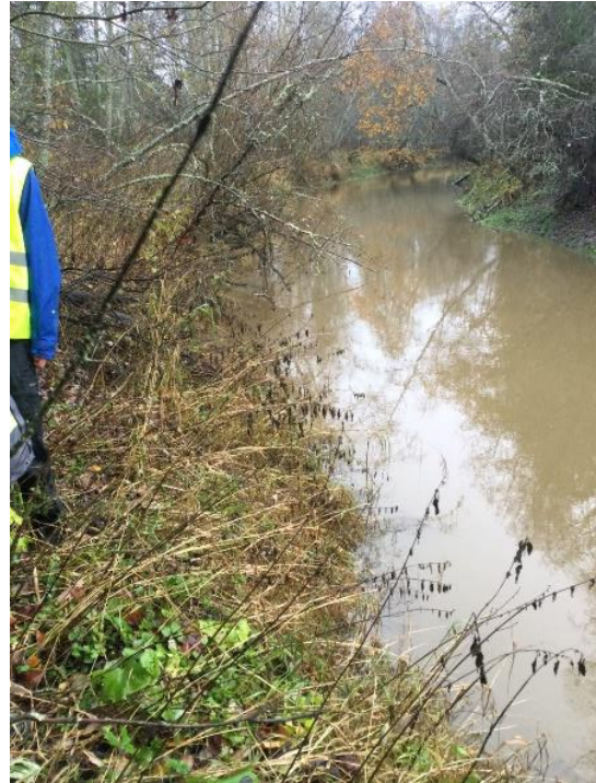
Figur 2-34: Profil 3. Mot nord. Lite erosjon.
