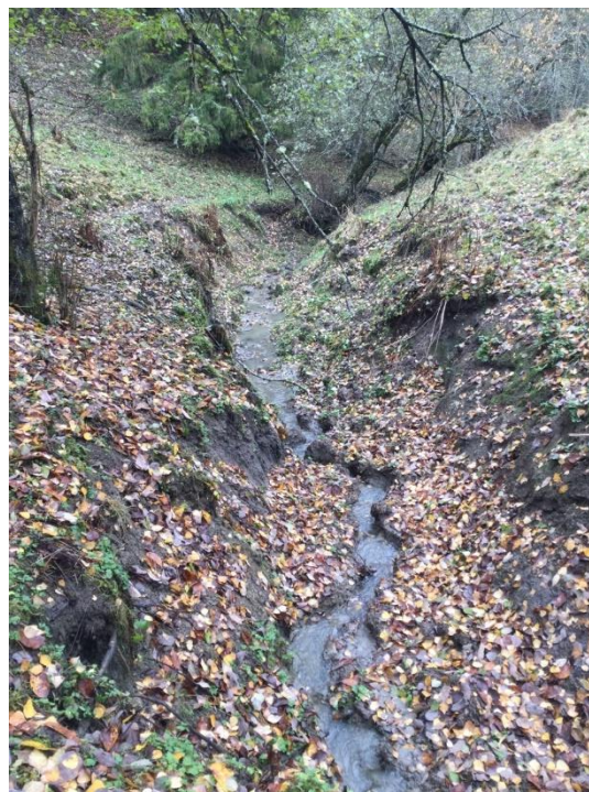
Figur 2-6: Vest for profil 7. Noe erosjon.
