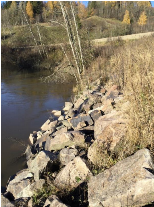
Figur 2-57: Profil 1a. Mot nord. Steinsatt yttersving som erosjonstiltak.
